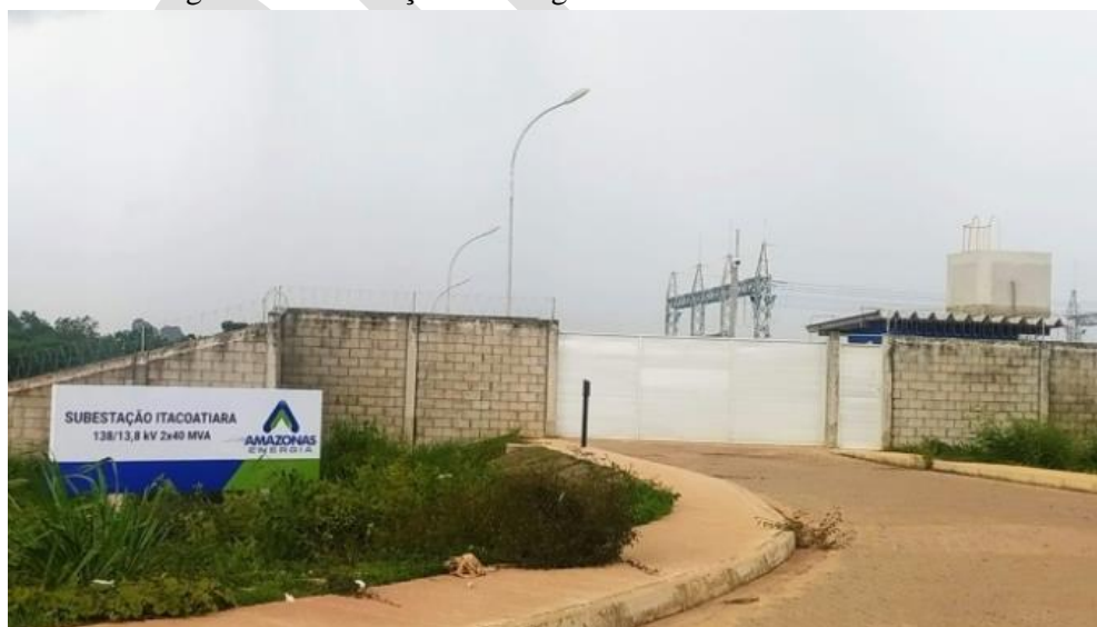
Figura 31. Subestação de energia elétrica em Itacoatiara/AM.
