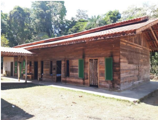
Figura 11 - Alojamentos da base operacional.
