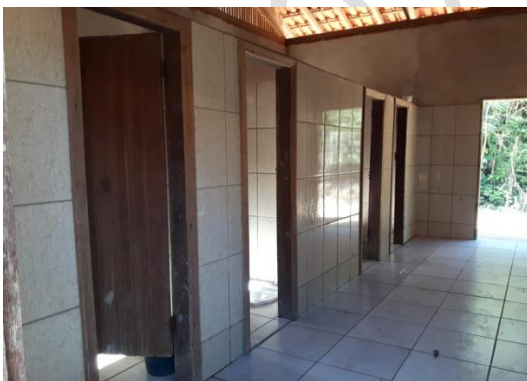
Figura 13 - Banheiros da base operacional.
