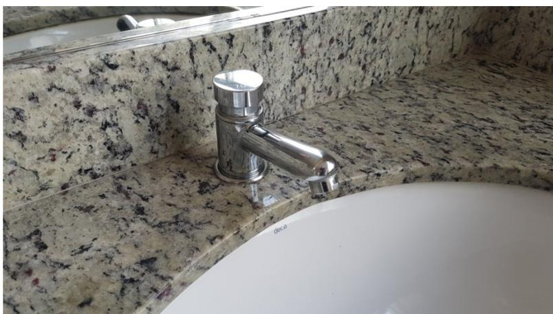
Figura 7 – Torneira temporizadas instaladas no Bloco B.
