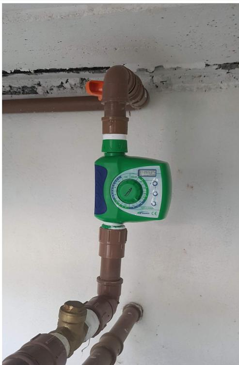
Figura 6 – Instalação de válvula temporizadora que permite o abastecimento do reservatório superior sem a utilização do sistema de bombas.
