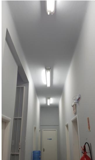
Figura 2 – Lâmpadas tubulares de LED instaladas no bloco B.
