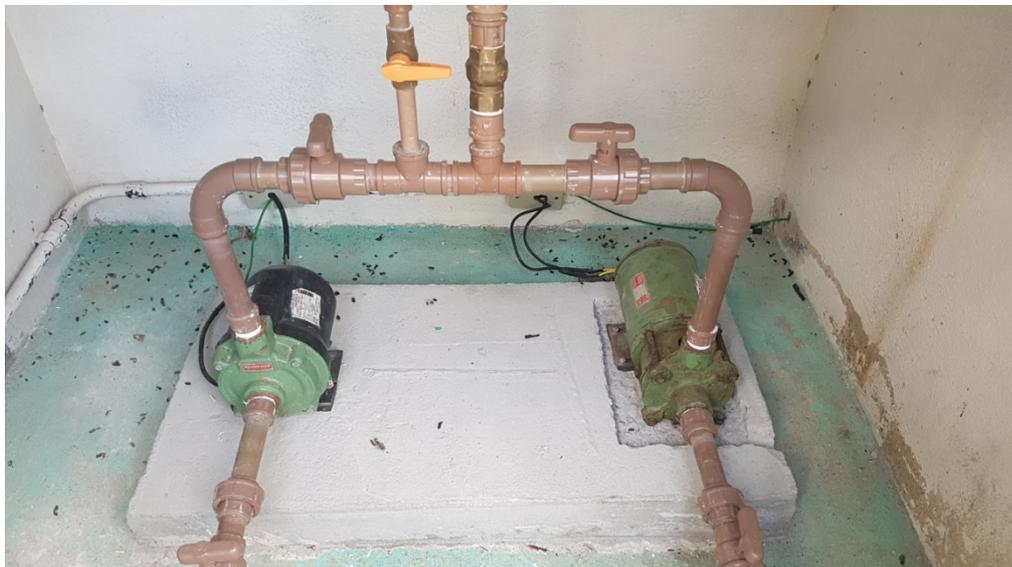
Figura 5 – A esquerda nova bomba de recalque com menor potência
