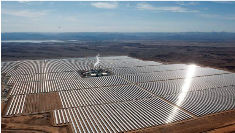
Figura 4 - Complexo Noor Ouarzazate, estação de energia solar
