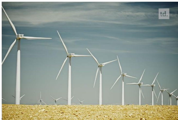
Figura 3 - Parque eólico de Tarfaya
