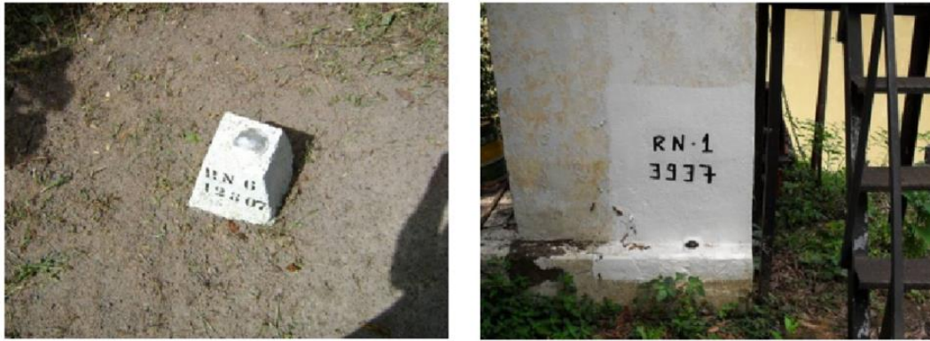
Figura 2 - Exemplo de RNs instaladas (ANA, 2012).
