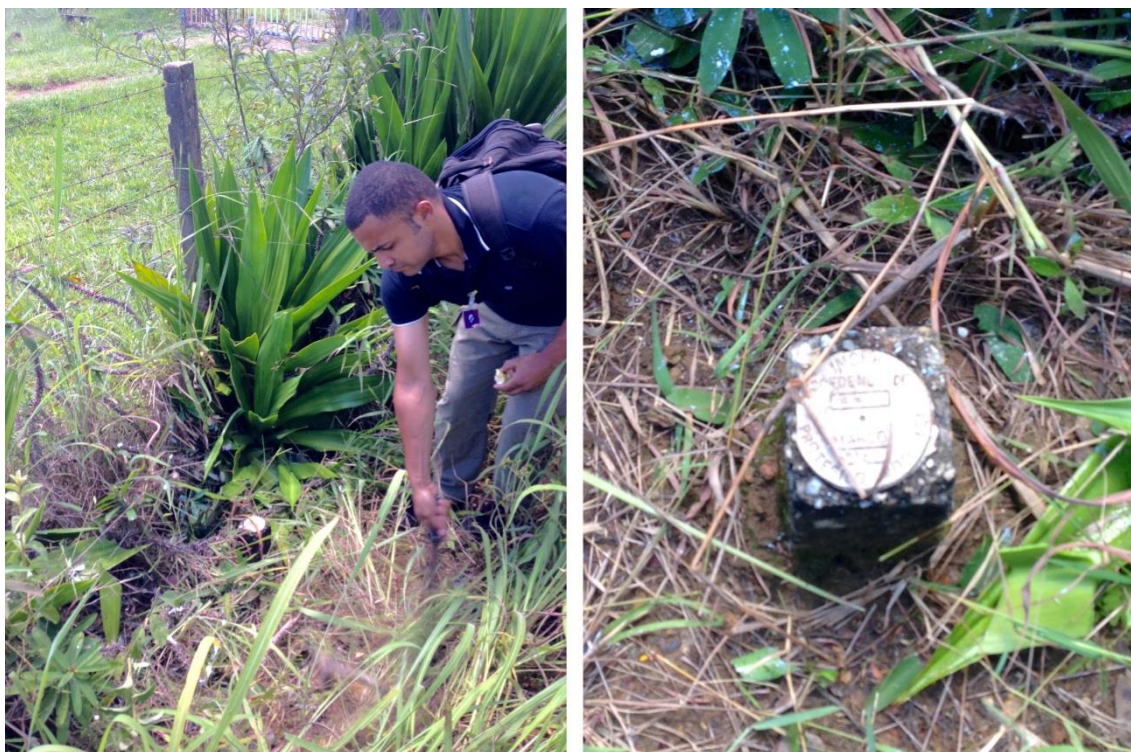
Figura 12: Limpeza da área próxima ao marco geodésico - AAG-M-0128.
