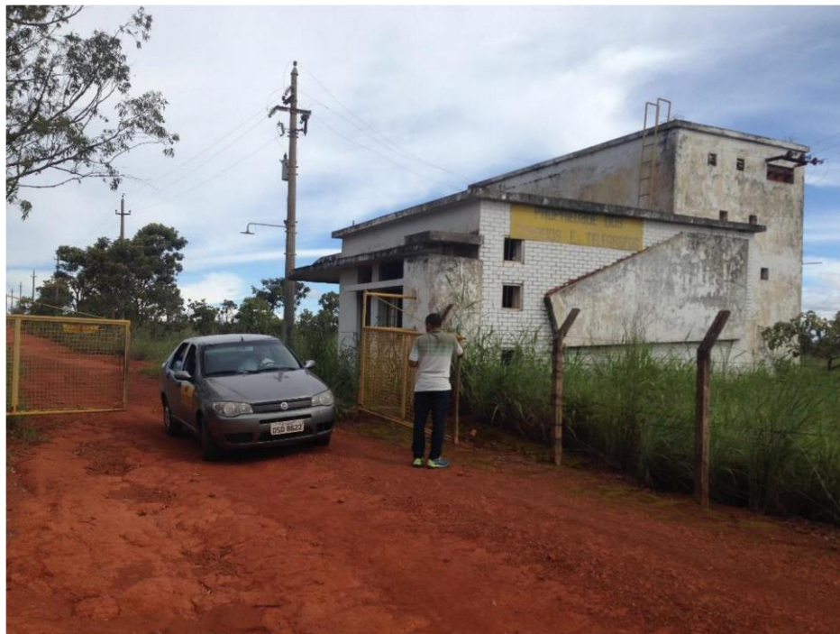
Figura 02: Portão da propriedade dos Correios e Telégrafos
