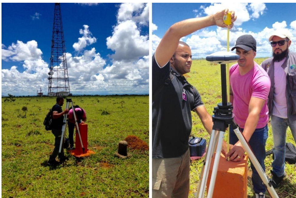
15: Instalação do tripé e do receptor no marco geodésico do IBGE – “SAT 91137”.
