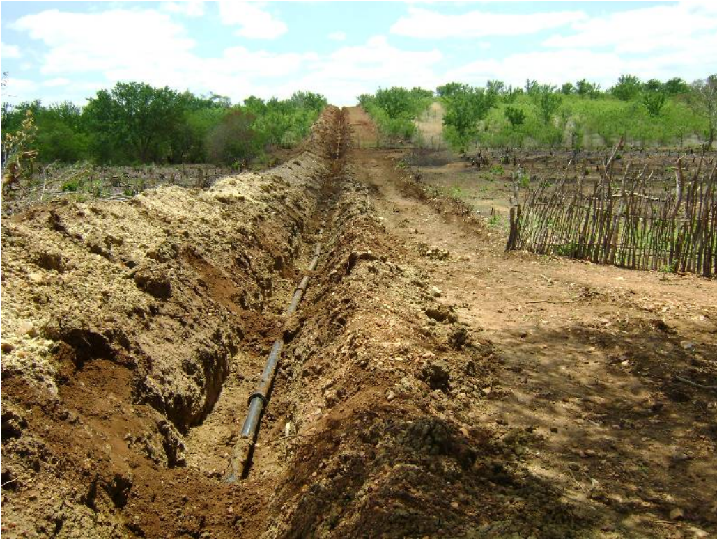
Foto 11 — Implantação do ramal III do Sistema Adutor do Oeste-PE.
