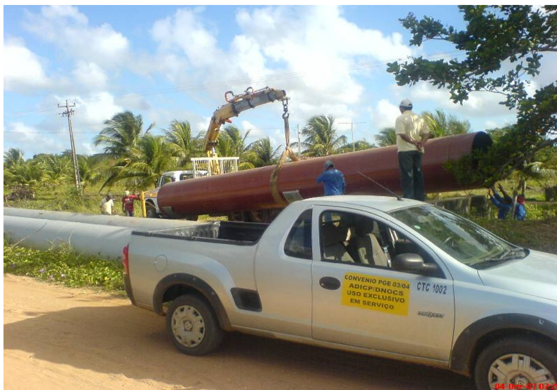
Foto 8 - Recuperação da adutora do perímetro irrigado Curu Paraipaba-CE.
