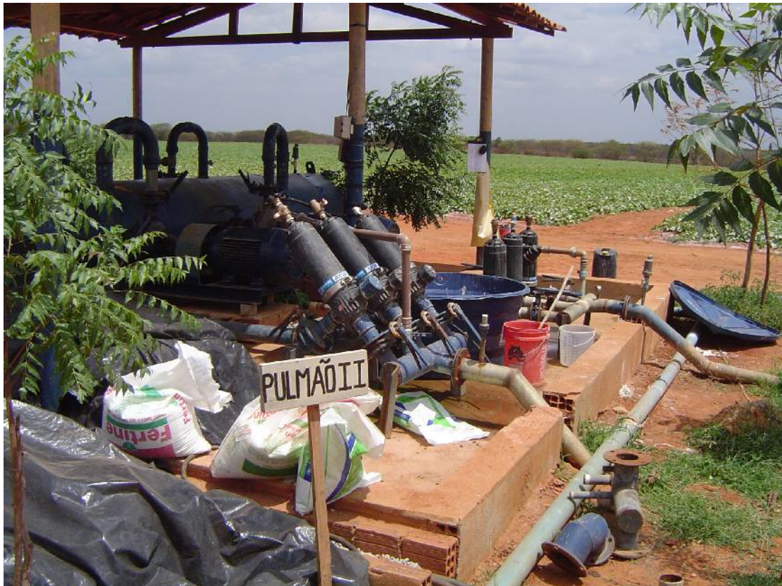
Foto 5 - Sistema injetor para ferti-irrigação por gotejamento. Tabuleiros de Russas-CE
