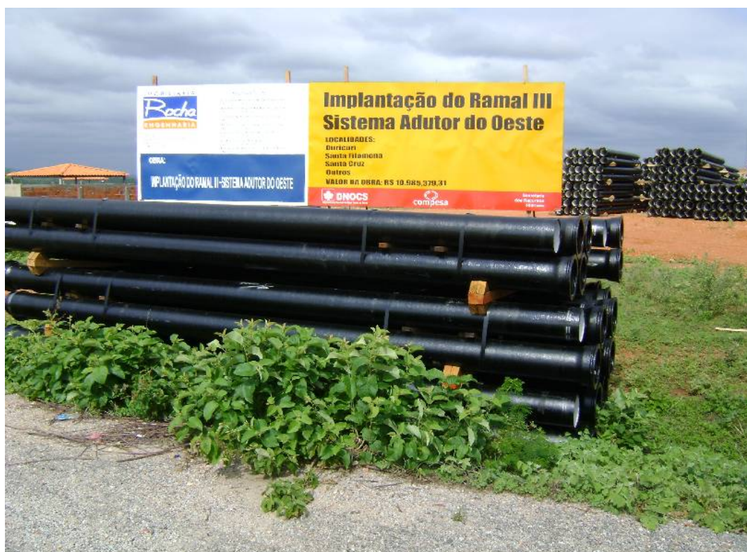
Foto 10 - Implantação do ramal III do Sistema Adutor do Oeste-PE.
