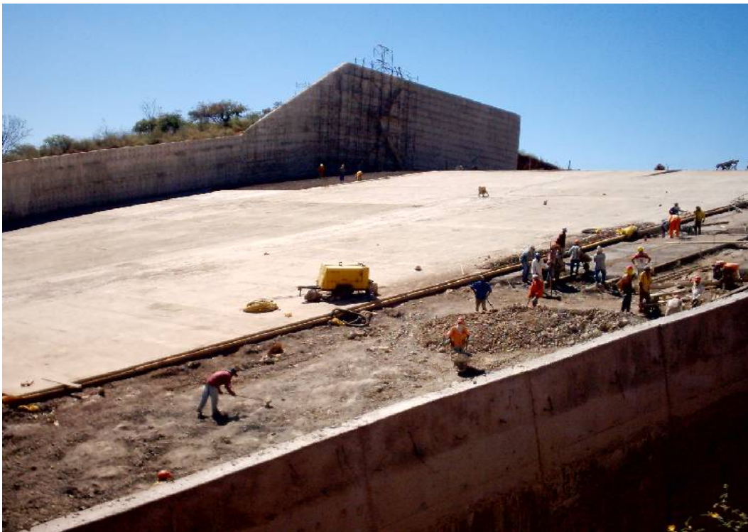
Foto 12 - Barragem Piaus. Concretagem do vertedouro-PI.
