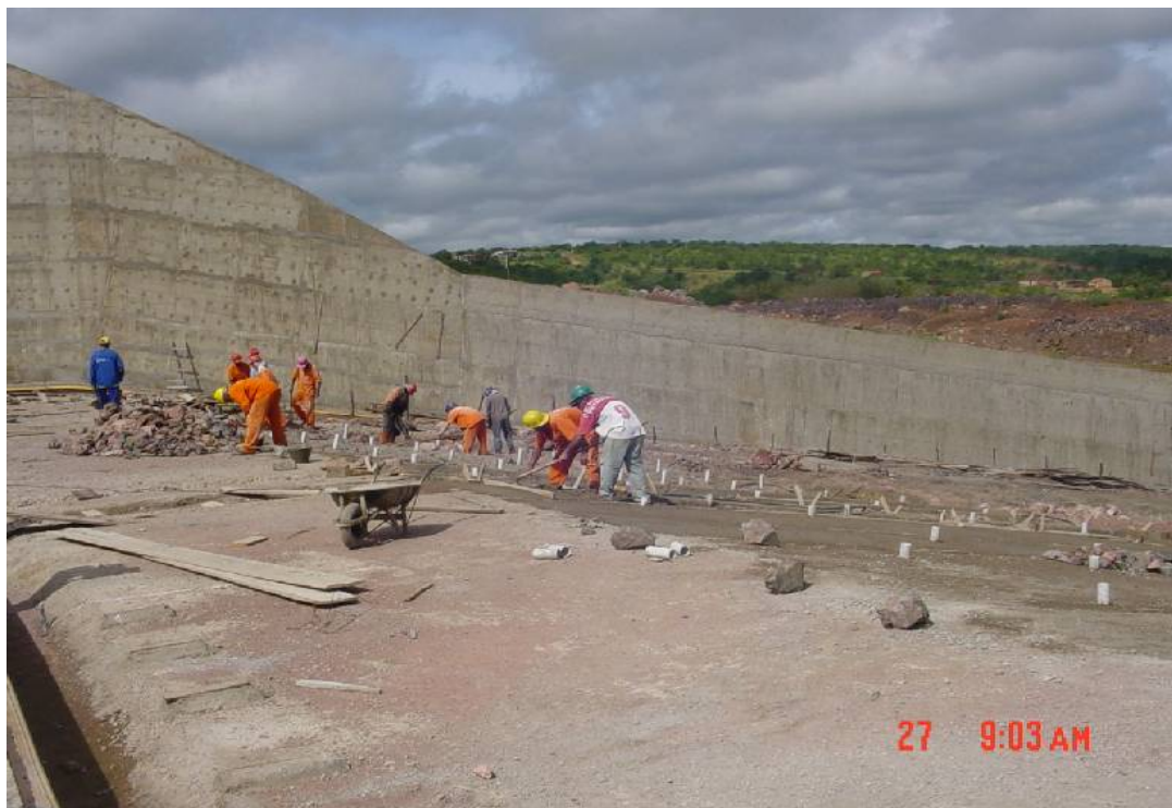
Foto 12 – Concretagem do vertedouro. Barragem Piaus-PI.
