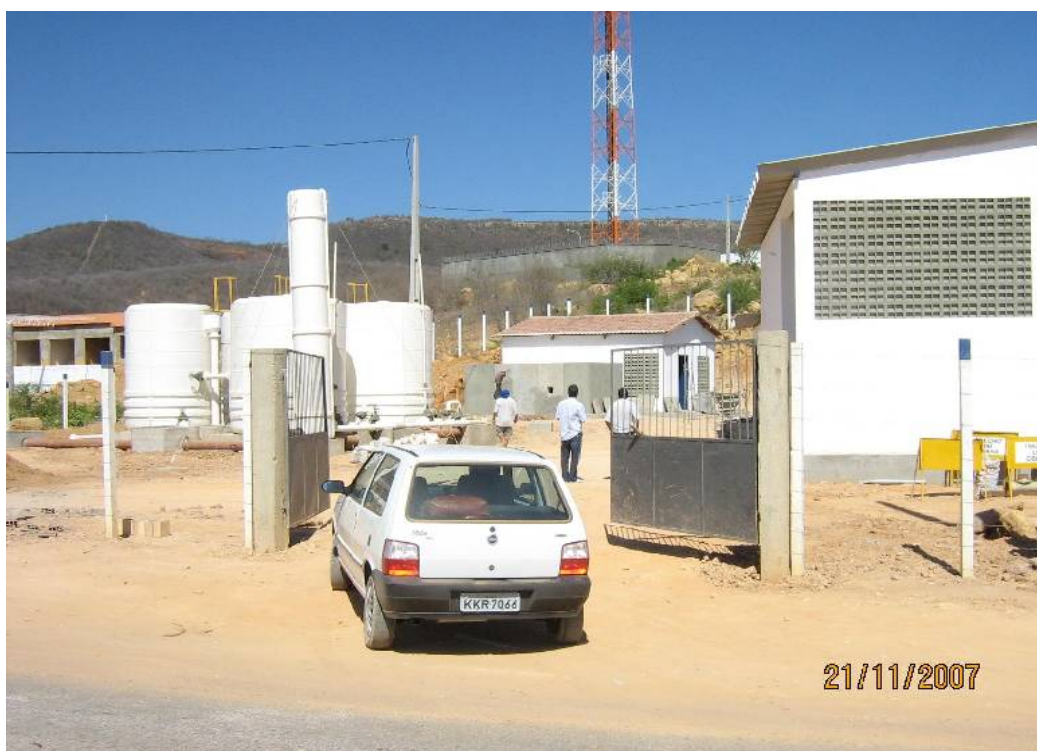
Foto 9 – Estação de tratamento de água. Ipupi-PE.
