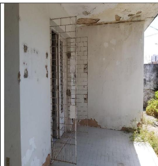
Figura 26 - Entrada da Casa – estado avançado de deterioração
