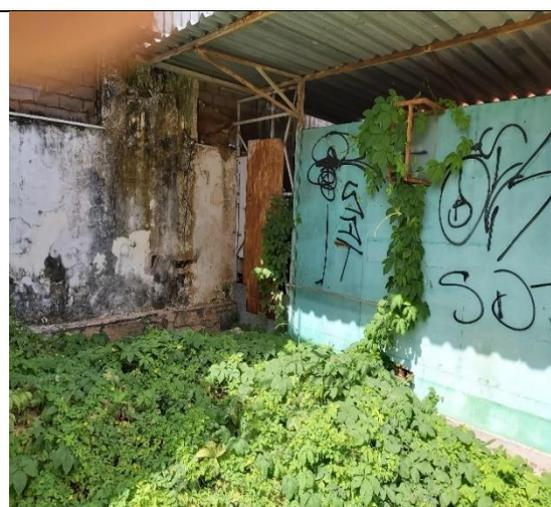
Figura 23 - Parte de trás do Imóvel, sinais de completo abandono e sem manutenção
