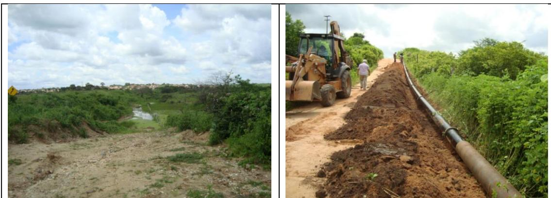
*Foto – Adutora de São Luís do Curu – Início de trecho enterrado em PVC DEFOFO, entre as Est. 875 a 956 (1.620m), pendente de execução; Execução de pequeno trecho enterrado (Est. 115) em aço COR-TEN, São Luís do Curu (CE), 20 de abril de 2017.*
