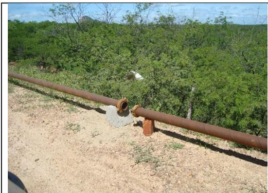
*Foto – Descontinuidade no assentamento da tubulação em aço Cor-Ten entre as estacas 456 a 470. Mineiro (CE), 03 de abril de 2017.*
