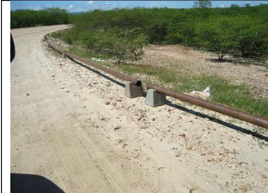
*Foto – Descontinuidade no assentamento da tubulação em aço Cor-Ten entre as estacas 349 a 360. Mineiro (CE), 03 de abril de 2017.*
