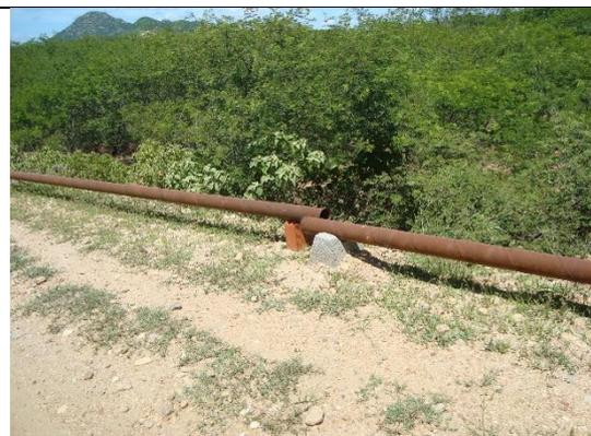
*Foto – Descontinuidade no assentamento da tubulação em aço Cor-Ten na estaca 505. Mineiro (CE), 03 de abril de 2017.*
