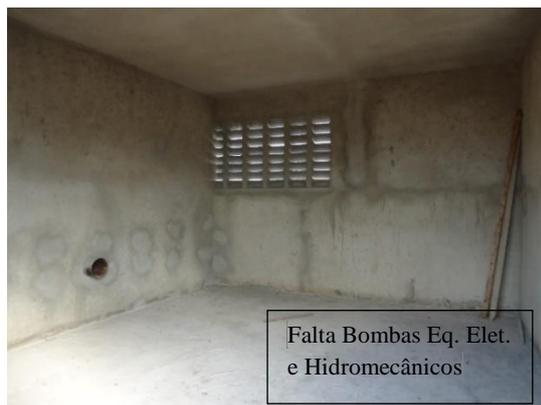
Foto – EB-2 – Executado apenas parte das obras civis, estando pendentes, ainda, Tubos Válvulas e Conexões; Bombas e Equipamentos Elétricos, Iracema (CE), 28 de junho de 2017.
