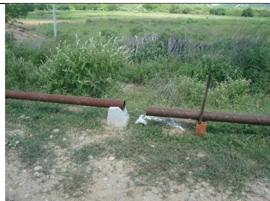
*Foto – Descontinuidade no assentamento da tubulação em aço Cor-Ten na estaca 611. Mineiro (CE), 03 de abril de 2017.*
