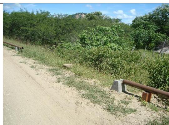
*Foto – Descontinuidade no assentamento da tubulação em aço Cor-Ten entre as estacas 627 a 637. Mineiro (CE), 03 de abril de 2017.*
