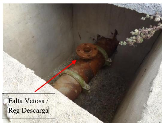
Foto – Não foram executados os Blocos de Ancoragem e também não foram instaladas as Ventosas e Registros de Descargas, Iracema (CE), 28 de junho de 2017.
