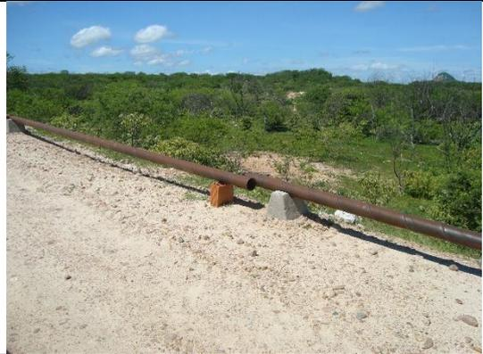
*Foto – Descontinuidade no assentamento da tubulação em aço Cor-Ten entre as estacas 411 a 412. Mineiro (CE), 03 de abril de 2017.*
