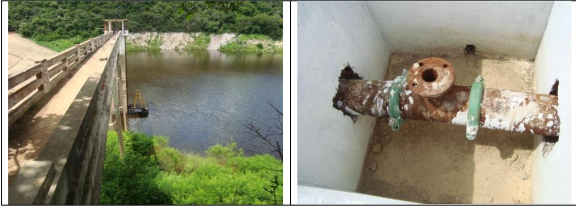
*Foto – Adutora de Apuiarés – Flutuante pendente de instalação das bombas, Tubos PEAD e parte elétrica; Caixa de passagem (Est. 402) pendente de instalação de Ventosa, General Sampaio(CE), 20 de abril de 2017.*
