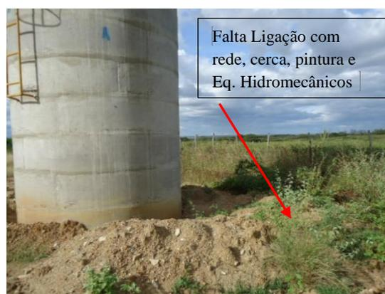
Foto – Obras civis dos 02 Reservatórios executadas parcialmente e pendentes de instalação dos equipamentos hidromecânicos, Iracema (CE), 28 de junho de 2017.
