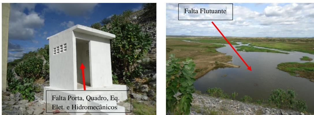
*Foto – EB-1 – Executado apenas parte da Casa de Comando, estando pendente o Flutuante; Tubos, Válvulas e Conexões; Bombas e Equipamentos Elétricos, Iracema (CE), 28 de junho de 2017.*
