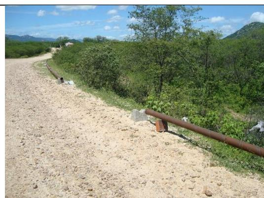
*Foto – Descontinuidade no assentamento da tubulação em aço Cor-Ten entre as estacas 660 a 670. Mineiro (CE), 03 de abril de 2017.*
