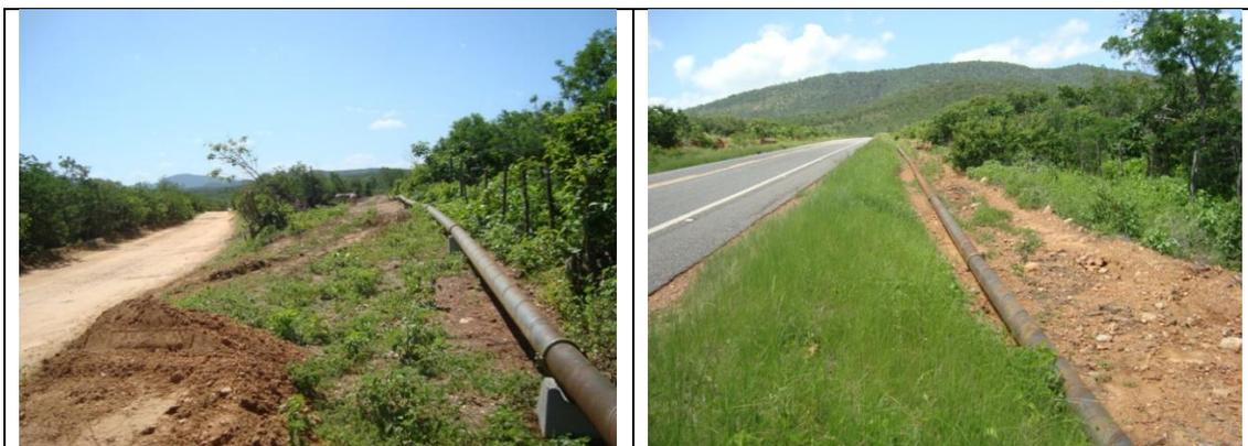
Foto – Montagem de Tubos em aço COR-TEM, sendo que parte da tubulação ainda não está sequer apoiada – Adutora de Pereiro – Lote I, Pereiro (CE), 06 de abril de 2017.
