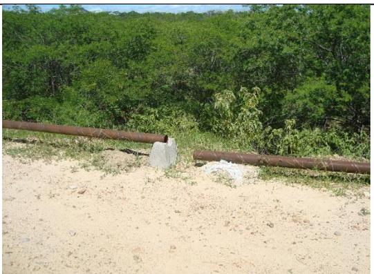
*Foto – Descontinuidade no assentamento da tubulação em aço Cor-Ten entre as estacas 470 a 485. Mineiro (CE), 03 de abril de 2017.*
