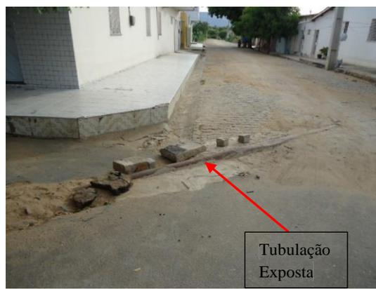
Foto – Falhas na execução: Tubulação passando por dentro de propriedade privada; Tubulação exposta e já amassada, Iracema (CE), 28 de junho de 2017.
