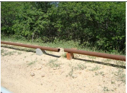
*Foto – Descontinuidade no assentamento da tubulação em aço Cor-Ten entre as estacas 485 a 505. Mineiro (CE), 03 de abril de 2017.*
