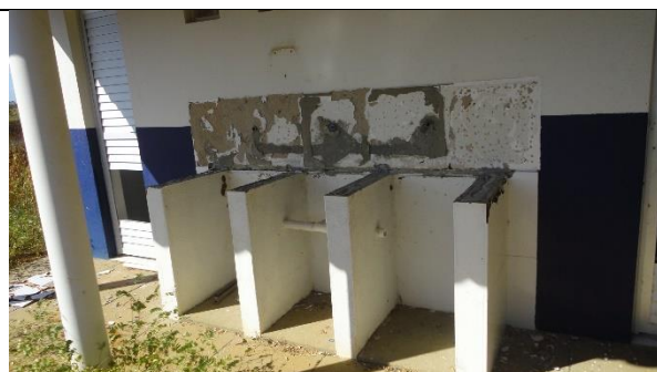
Foto 08 – Vista geral do ponto onde havia sido instalado equipamento hidrossanitário no prédio da administração, mostrando que o mesmo foi furtado. Apodi/RN – 09/06/2016.
