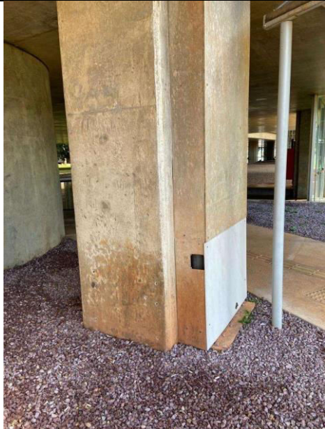
Pilar onde será feita a infraestrutura de hidráulica.
