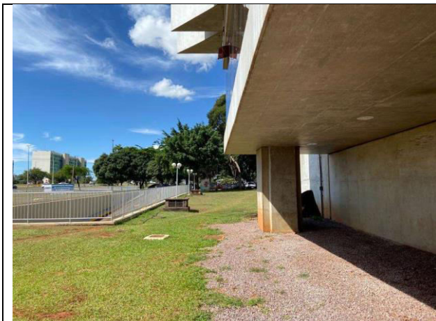
Foto do acesso a Compostagem e pilar onde poderá ser locada a placa de identificação.
