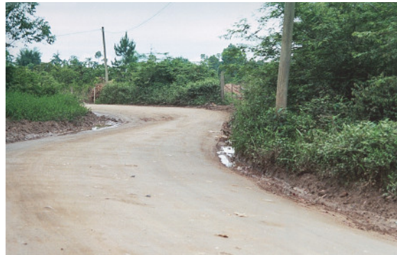
figura 5 - Exemplo de via rural com severidade baixa de drenagem deficiente.
