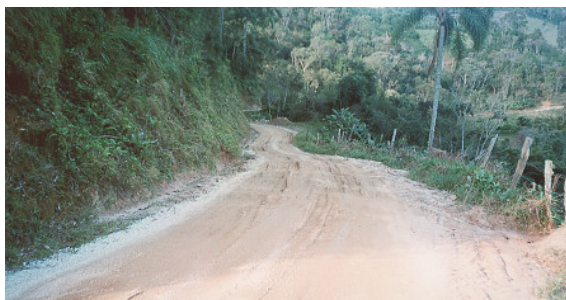
figura 3 - Exemplo de via rural com severidade média de seção transversal imprópria.
