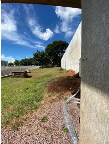
Vista frontal - Área de acesso.
