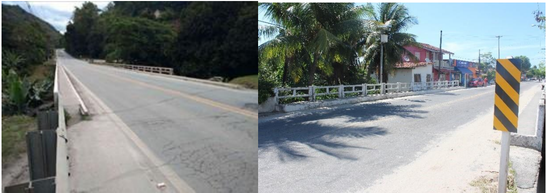
Figura 3.3: Vista da entrada da ponte.
