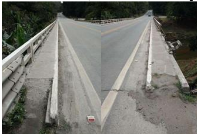
Figura 3.4: Vista superior na linha dos drenos de ambos os lados
