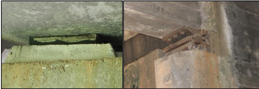
Figura 4.9: Aparelho de apoio sujo.
