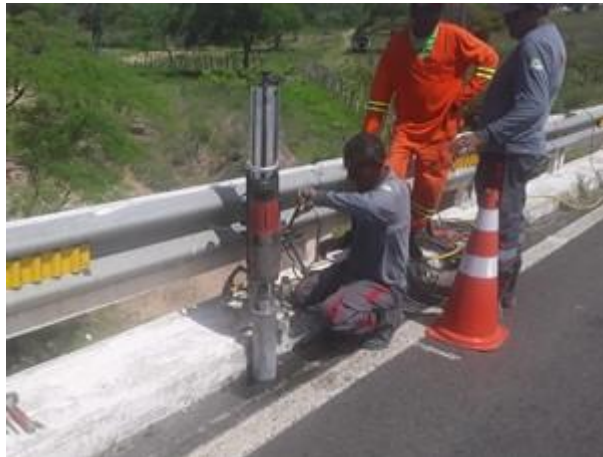
Figura 4.12: Execução do serviço de recomposição de dreno em Obra de Arte Especial.
