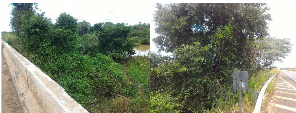
Figura 3.6: Levantamento fotográfico da vegetação circundante à estrutura.
