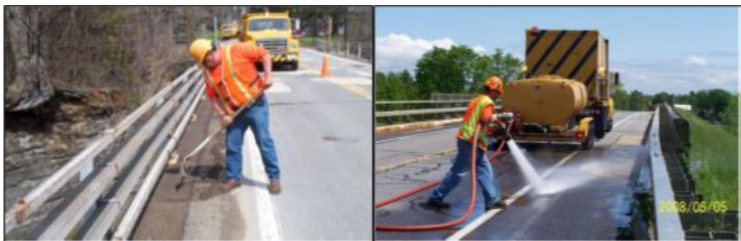
Figura 4.4: Serviço de limpeza da pista de rolamento (NYSDOT, 2008).
