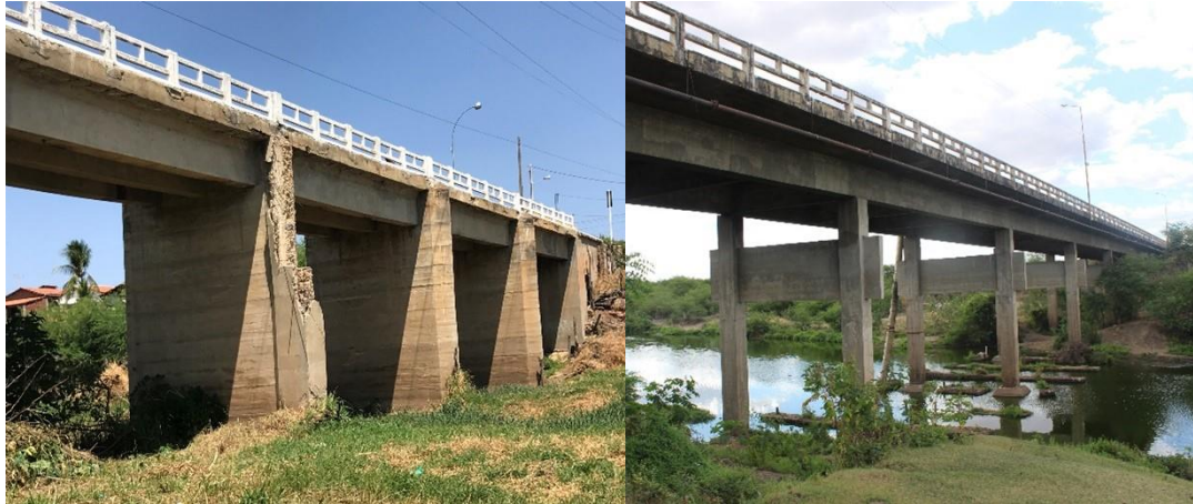
Figura 3.7: Exemplo de vista lateral da ponte .
