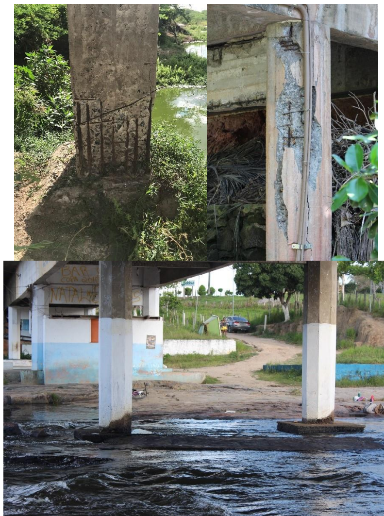
Figura 3.12: Exemplo de registros de condição dos pilares.
