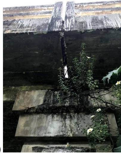
Figura 3.11: (a) Exemplo de registro das condições de apoio; (b) Exemplo de registro da parte inferior das juntas de dilatação.
