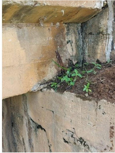
Figura 3.11: (a) Exemplo de registro das condições de apoio; (b) Exemplo de registro da parte inferior das juntas de dilatação.
