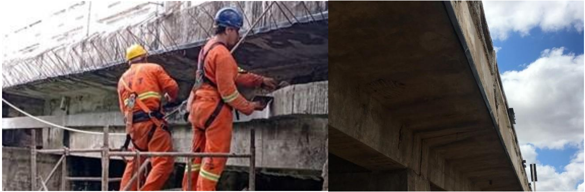
Figura 4.15: Execução do serviço de instalação de pingadeira de elastômero.
