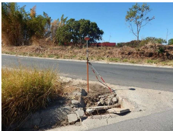
Figura 4: Exemplos de feições não fotoidentificáveis - sarjeta coberta por vegetação de gramínea (esquerda) e canteiro danificado (direita).
