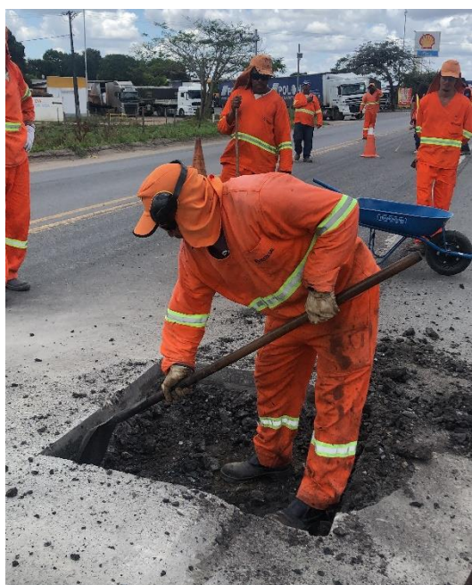
a) Abertura da janela de inspeção no segmento (Fonte: Almeida et al. , 2022)
