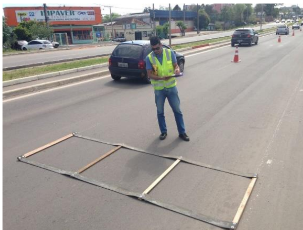
Figura 22 – Execução do levantamento dos defeitos
