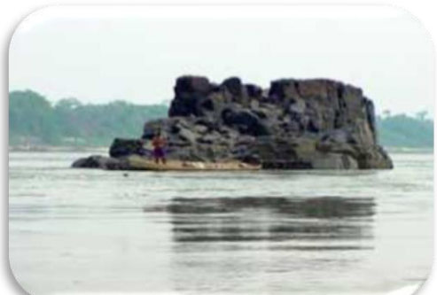
Derrocamento do Pedral do Lourenço
