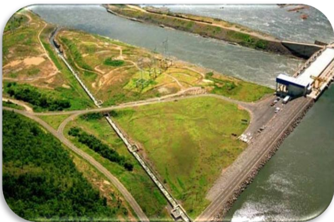
Eclusa de Lajeado / Hidrovia do Tocantins
