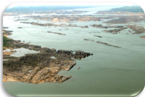
Derrocamento do Pedral do Lourenço
