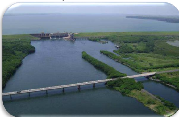
Reforço das proteções dos pilares da ponte da rodovia BR-153
