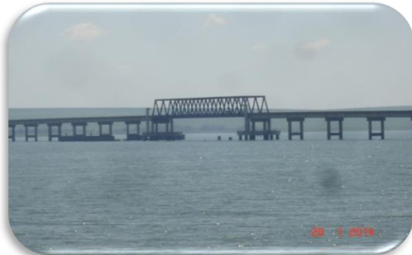
Proteção da Ponte da SP 333
