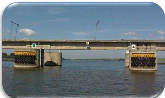
Ampliação do Canal / Ponte Ayrosa Galvão
