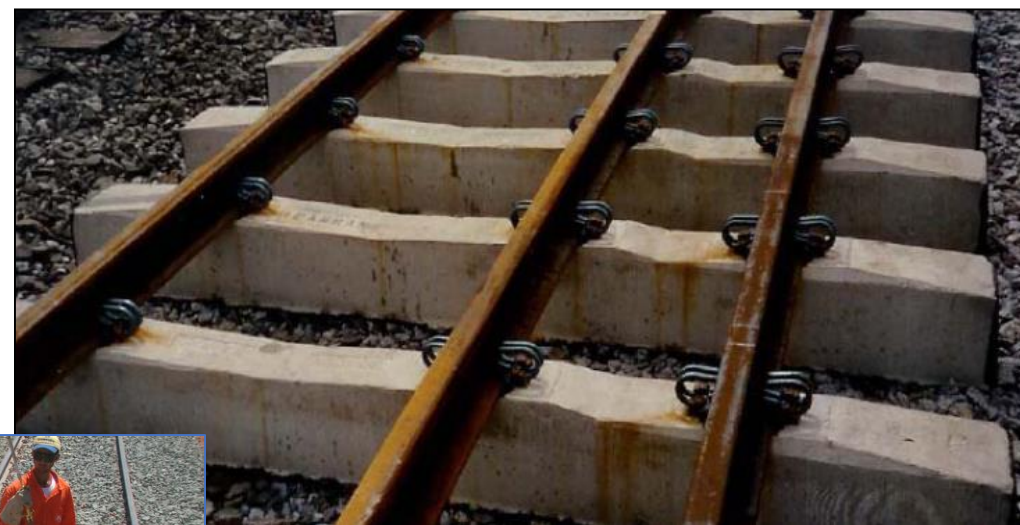
Assentamento de grade
