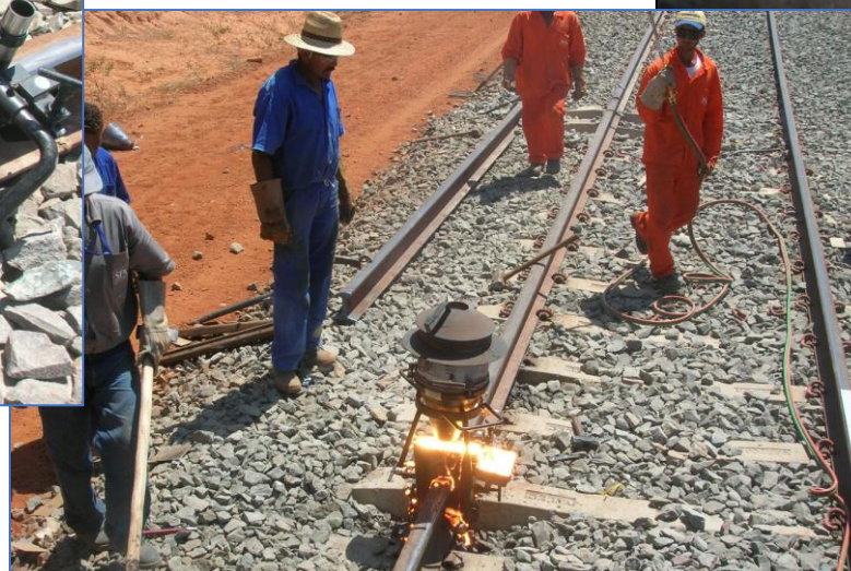
Soldagem de trilhos
