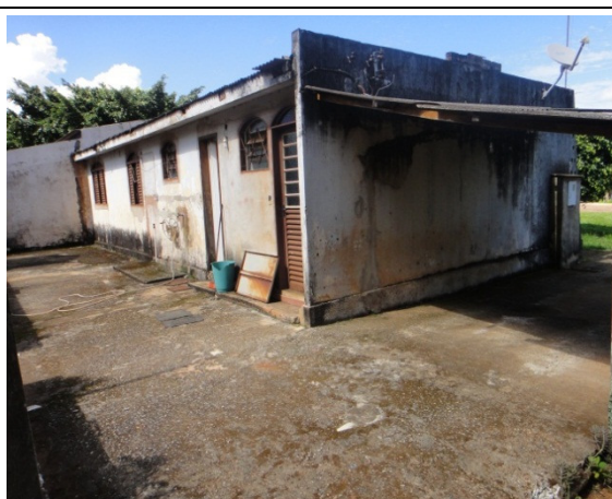
Casa nº 34 - Imóvel ocupado por servidora aposentada do extinto DNER
