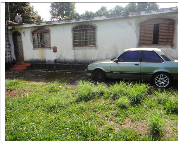
Casa nº 34 - Imóvel ocupado por servidora aposentada do extinto DNER
