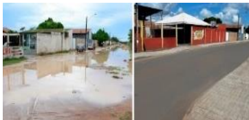
Pavimentação asfáltica/drenagem Boa Vista-RR
