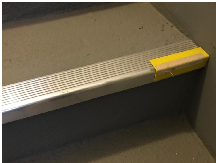
Imagem 01: Cantoneira de alumínio antiderrapante e cantoneira em PVC instaladas
