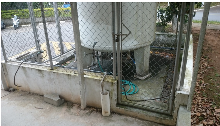
Figura 3: Piso capacidade para instalação de tanque estacionário de 10 toneladas.
