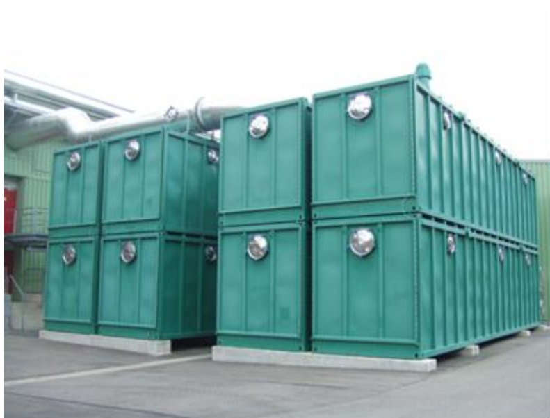
Figura 8 – Biofiltro fechado (contêineres) para o tratamento mecânico-biológico
