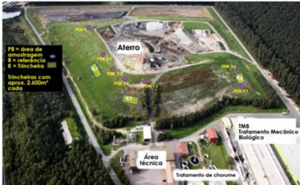
Figura 1 – Vista do aterro de Pohlsche-Heide com áreas de investigações
