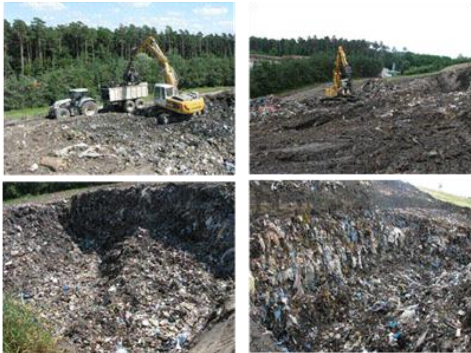
Figura 2 – Escavação dos resíduos das trincheiras
