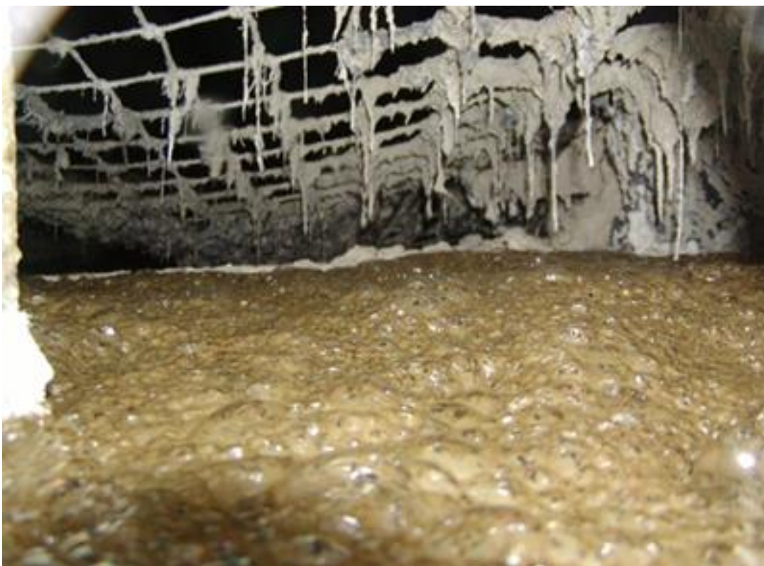
Figura 3 – Formação de estalactites de enxofre elementar, dentro de um biodigestor
