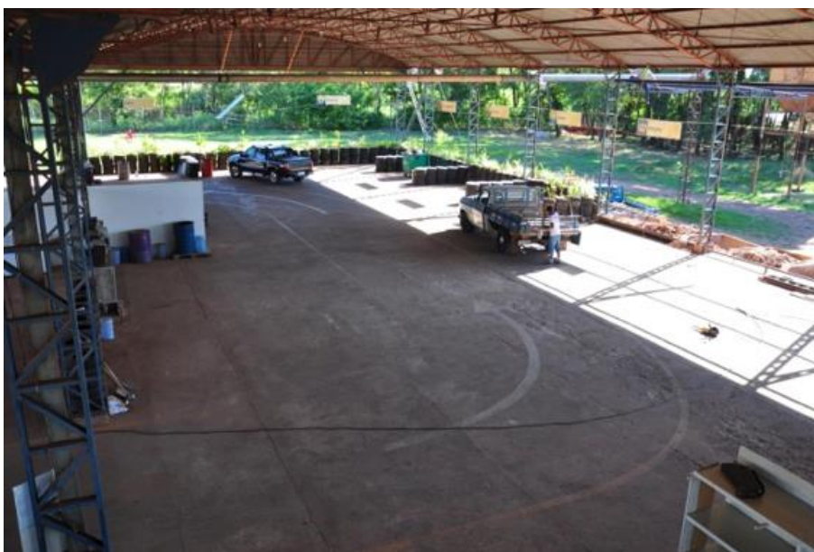
Figura 9 – Aspecto geral do interior barracão do ECOTUDO® Sul
