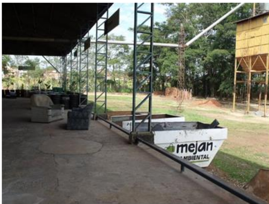
Figura 14 – Caçambas para depósito de resíduos da construção civil – ECOTUDO® Sul
