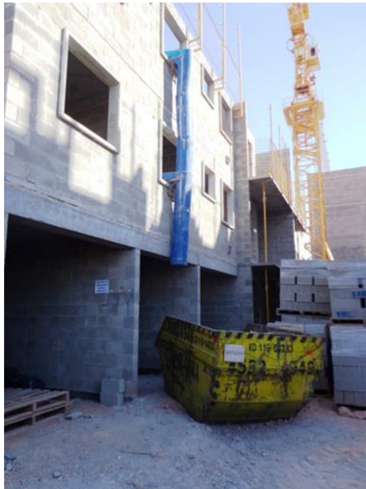
Figura 4 – Condutor de entulho em empreendimento da empresa analisada
