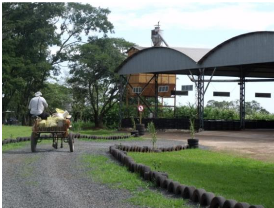
Figura 8 – Acesso ao barracão do ECOTUDO® Sul
