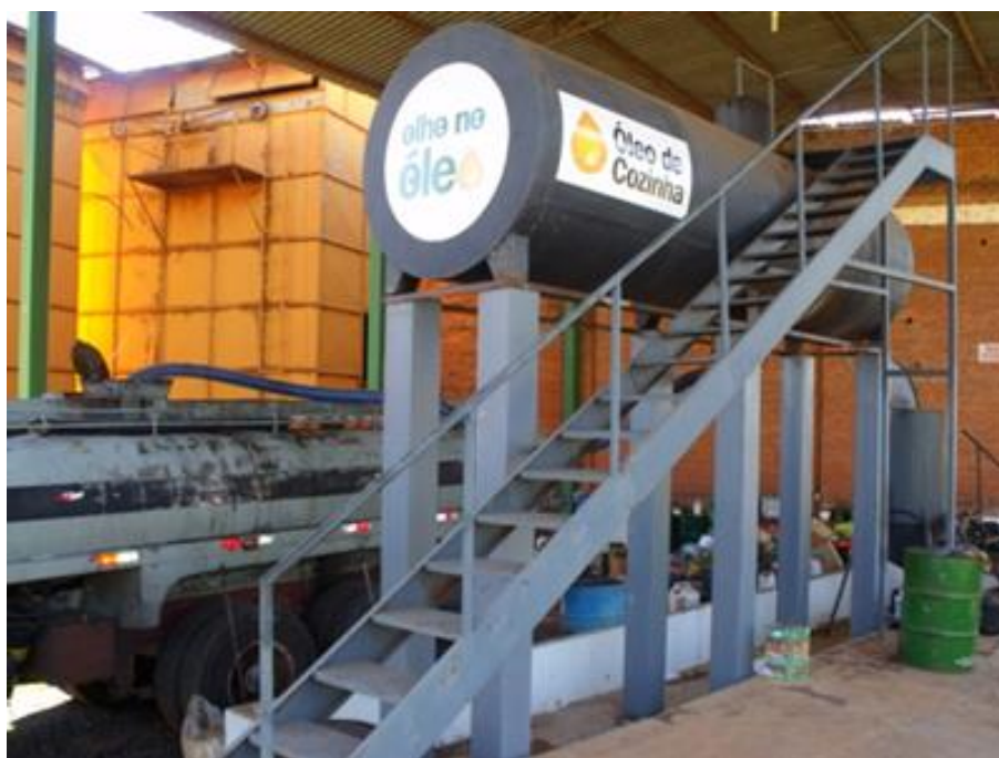
Figura 16 – Tanque de óleo de cozinha com carregamento em caminhão para produção de biodiesel – ECOTUDO® Sul
