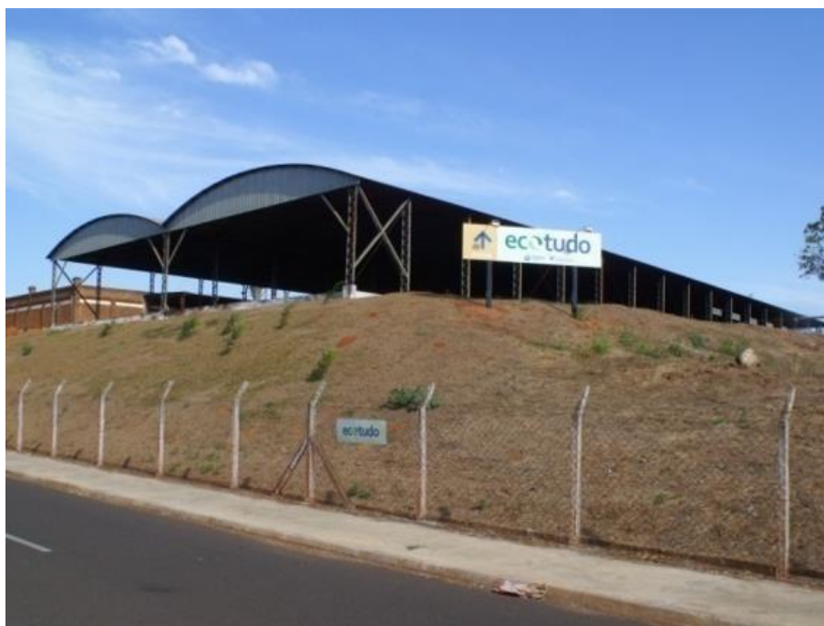
Figura 7 – Aspecto geral do barracão do ECOTUDO® Sul
