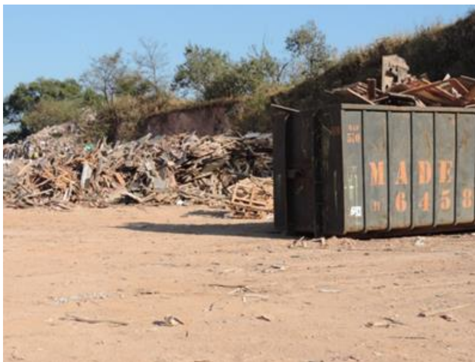
Figura 4 – Madeiras separadas no processo de triagem
