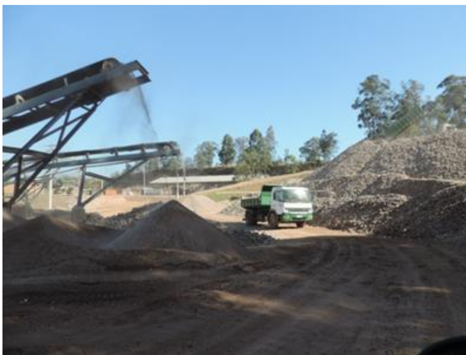
Figura 7 – Transporte dos resíduos triados para o processo de britagem
