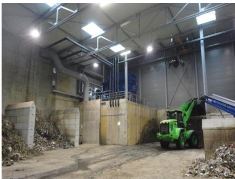
Figura 4 – Carregamento de resíduos sólidos orgânicos por ponte rolante
