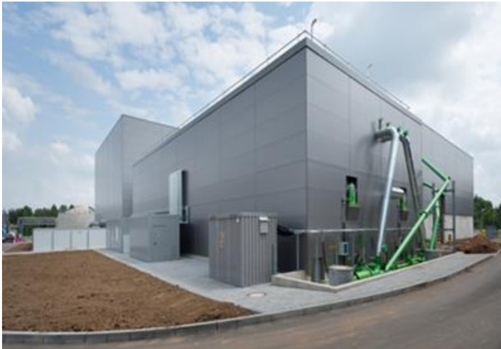
Figura 17 – Planta de Fulda (Alemanha) – dois biodigestores para 90 t/dia de orgânicos
