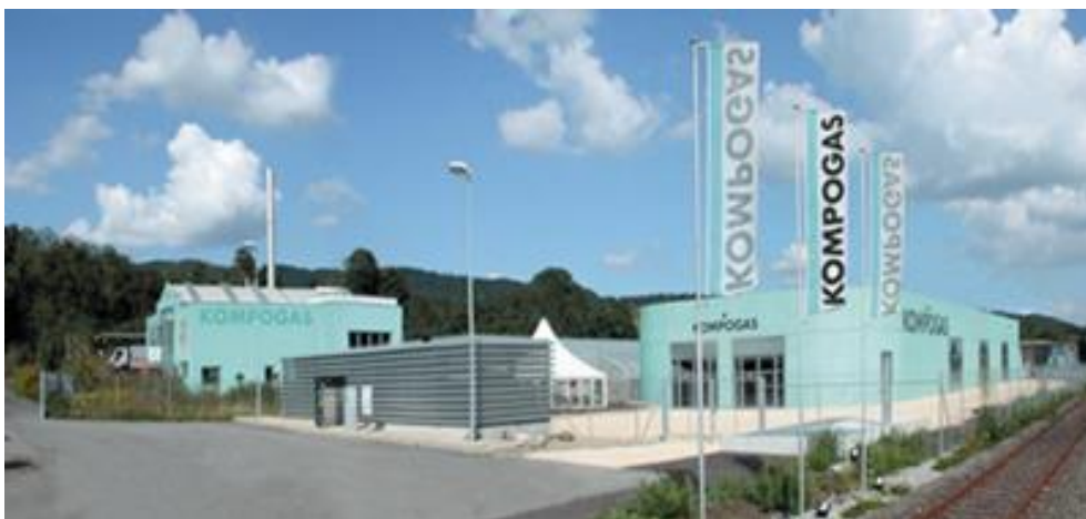
Figura 18 – Planta demonstrativa de Otelfingen (Suíça) – um biodigestor para 30 t/dia de orgânicos
