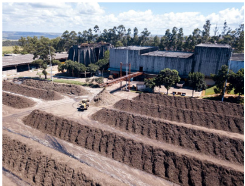
Leiras de compostagem na usina do SLU-DF. Foto: Soninha Vill/ProteGEer
