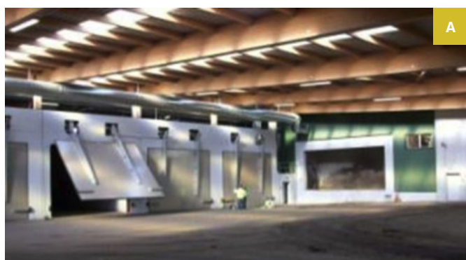
Figura 17: Detalhe da porta dos reatores e a forma de abertura [A] e tanque de recirculação de lixiviado [B]
