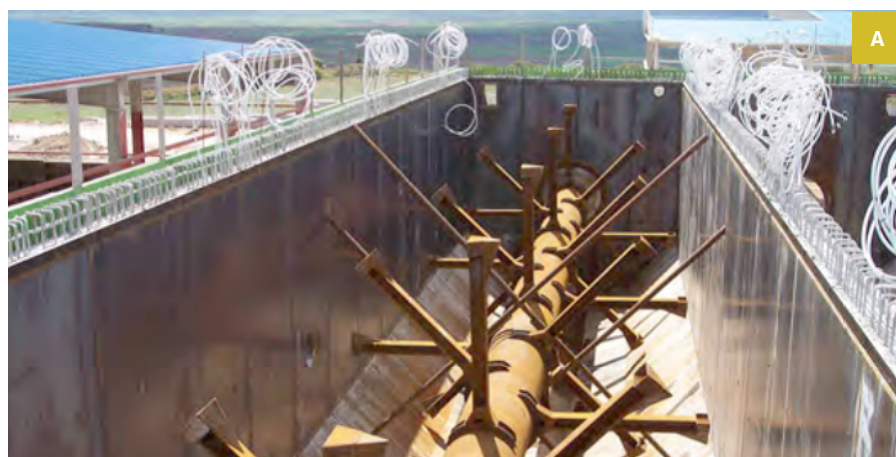
Figura 7: Na figura [A] um detalhe do sistema de agitação de um dos reatores construídos no Ecoparque de La Rioja e na figura [B] é apresentado um modelo esquemático de um reator com tecnologia Kompogas.
