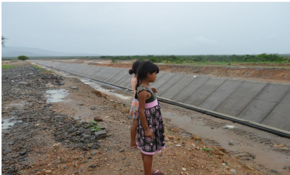
Floresta / PE – Canal de transposição de água - Assentamento Serra Negra (Fonte: Programa Nacional de Saneamento Rural – PNSR)
