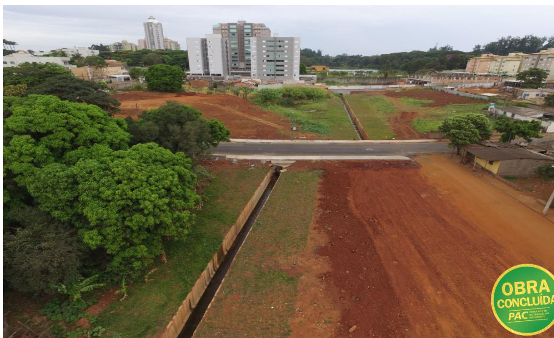
Uberaba / MG - Controle de Inundações e Drenagem das Áreas Adjacentes - População beneficiada: 3.434 famílias.
