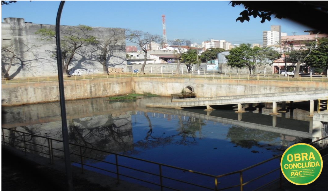
São Bernardo do Campo / SP – Implantação de bacia de detenção, elevatória, canalização do córrego Ipiranga e ampliação do sistema de microdrenagem - População beneficiada: 44.417 famílias.
