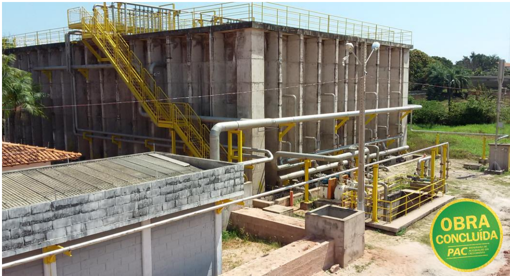
Santarém / PA – Implantação do Sistema de Esgotamento Sanitário - População beneficiada: 30 mil pessoas. Obra concluída em 2016
