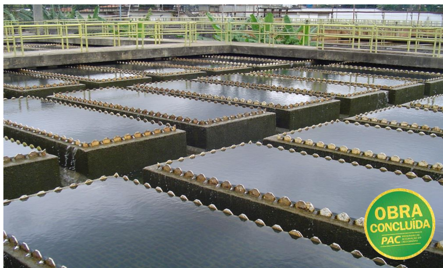
São Gonçalo / RJ – Duplicação da Adutora e Ampliação da Capacidade de Tratamento de Água do Sistema IMUNA - Laranjal (COMPERJ) - População beneficiada: 520.000 famílias. Obra concluída em 2016
