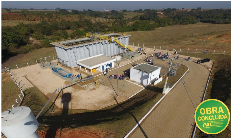
Arthur Nogueira / SP – Implantação do Sistema de Tratamento de Esgoto - População Beneficiada: 4.368 famílias. Obra concluída em 2016
