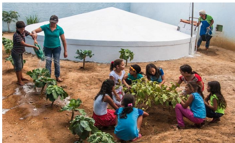
Igaci / AL – Escola Municipal Antônio Gomes de Araújo. O Projeto Cisternas nas Escolas tem como objetivo levar água para as escolas rurais do Semiárido utilizando cisternas de 52 mil litros como tecnologia social para o armazenamento de água pluvial.
