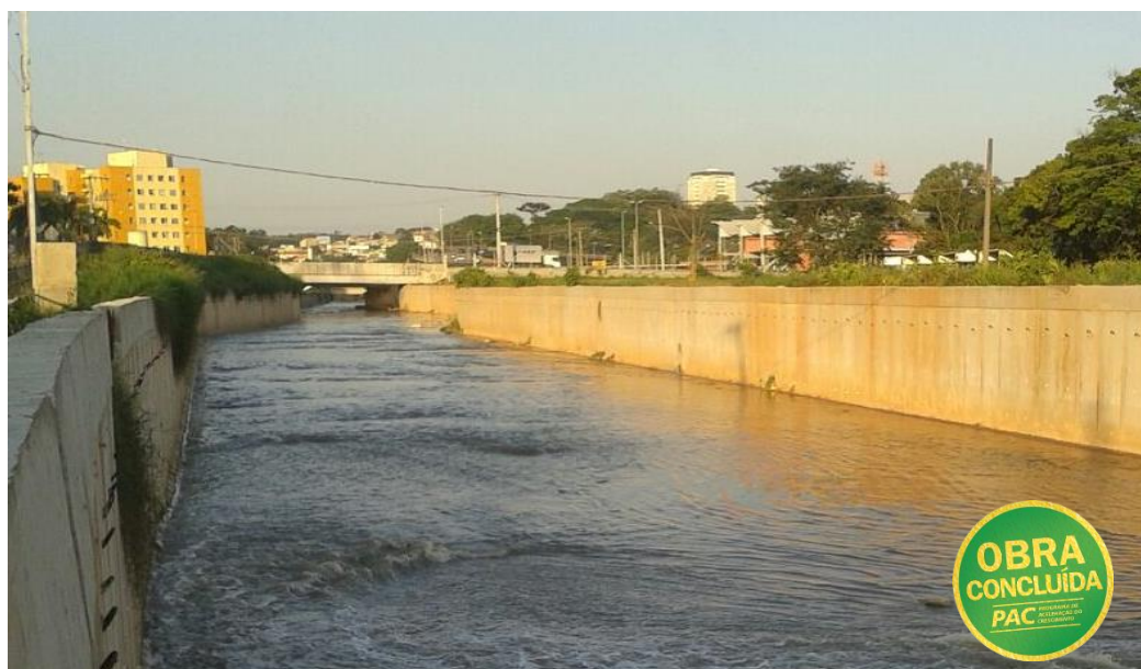
Jandira / SP – Drenagem Urbana Sustentável na Bacia do córrego Barueri Mirim - População beneficiada: 25.000 famílias. Obra concluída em 2016
