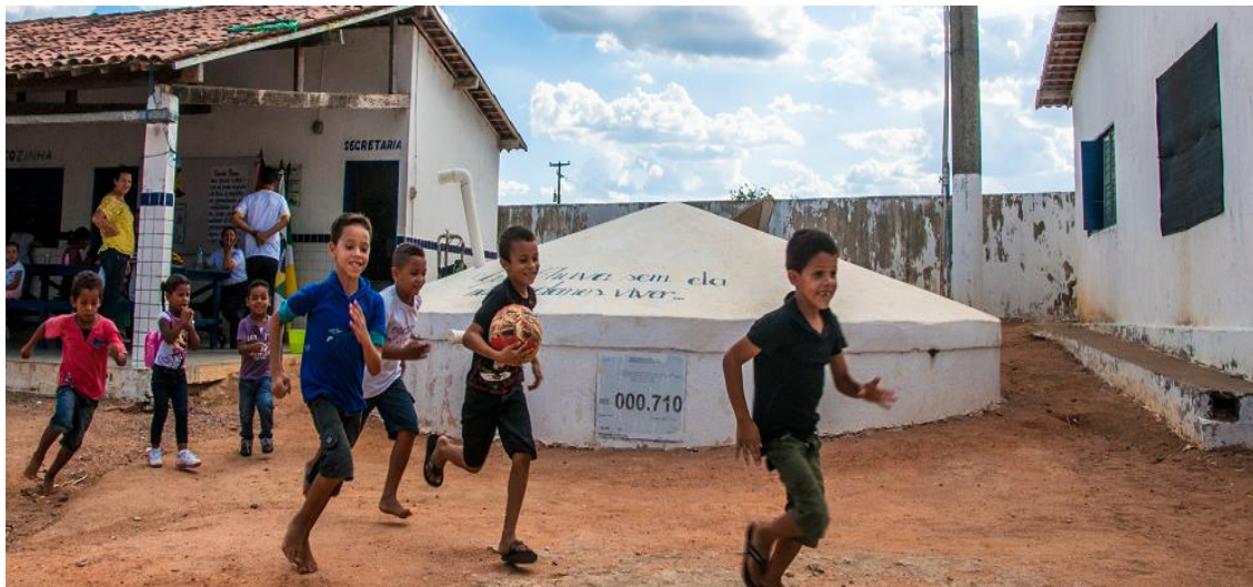
Arapiraca / AL – Escola de Ensino Fundamental Benjamim Felisberto da Silva Cisternas nas escolas - Programa que tem como objetivo levar água às escolas rurais do semiárido, utilizando cisterna de 52 mil litros como tecnologia social para armazenamento da água de chuva.
