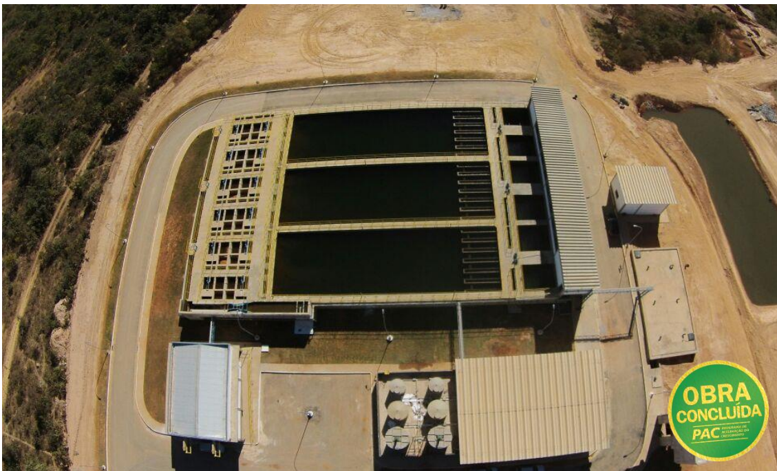
Sete Lagoas / MG – Estação de Tratamento de Água - População beneficiada: 54.376 famílias. Obra concluída em 2016
