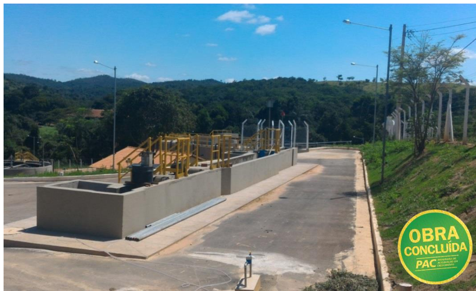
Jaboticatubas / MG – Ampliação do Sistema de Esgotamento Sanitário. Obra concluída em 2016
