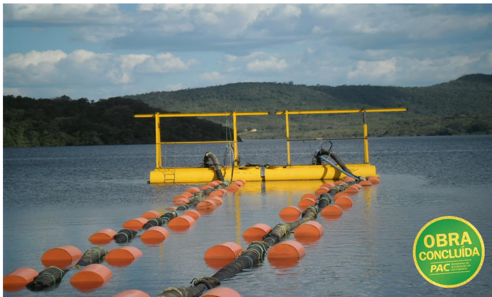
Piriri / PI – Ampliação do Sistema de Abastecimento de água - captação, elevatórias, adutoras, ETA, reservatórios, rede de distribuição e ligações prediais - População beneficiada: 5.475 mil famílias. Obra concluída em 2016
