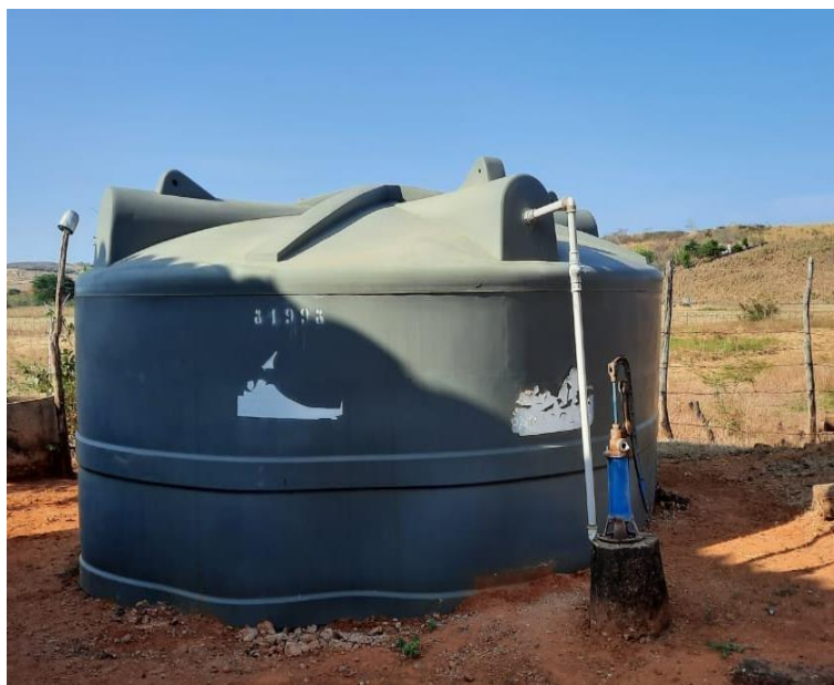
Imagem 6: cisterna de polietileno danificada pela ação do sol.
