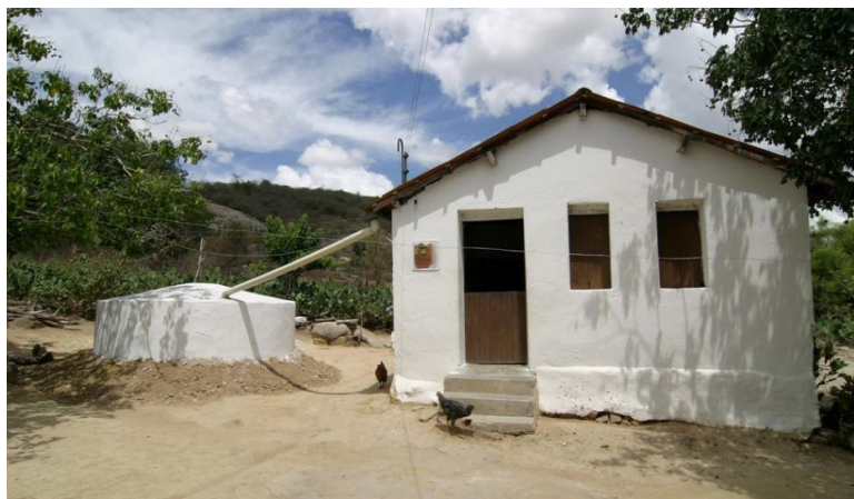
Imagem 4: cisterna de placas.
