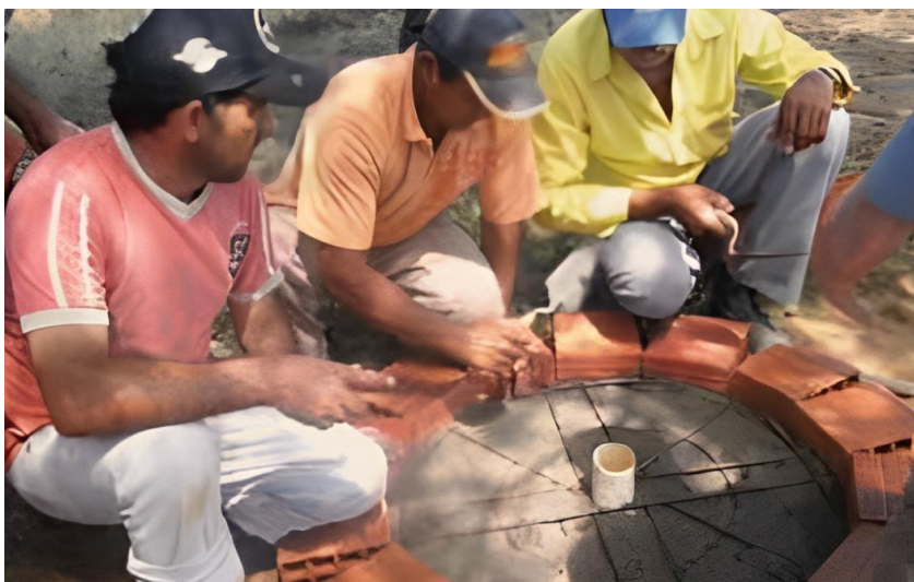
Imagem 10: construção do pião central.
