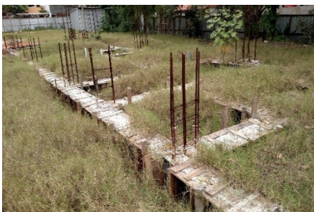
Obra paralisada – CIE São Gonçalo/RJ
