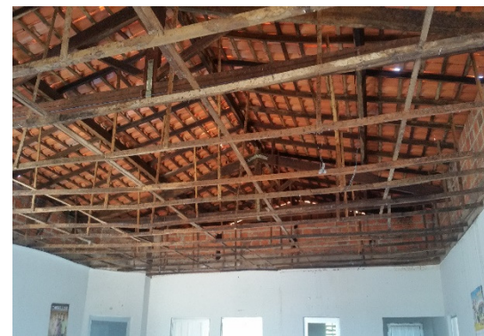
PSF – Vida, Monte Alegre/GO: Ralo “adesivado” como Infiltrações na porta de acesso “jardim de inverno” . PSF – Teto da recepção da UBS destruído, Aldeias Altas/MA. – Vida, Monte Alegre de Goiás/GO.
