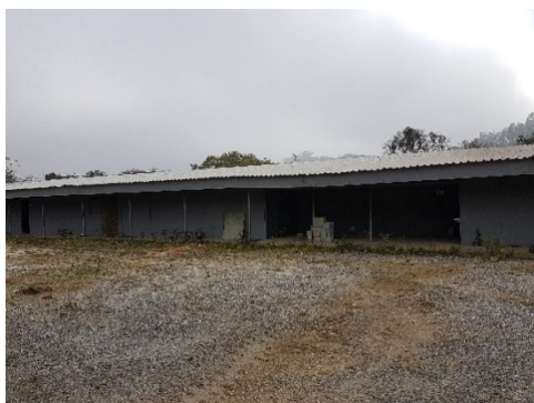
Obra paralisada, Guararema/SP
