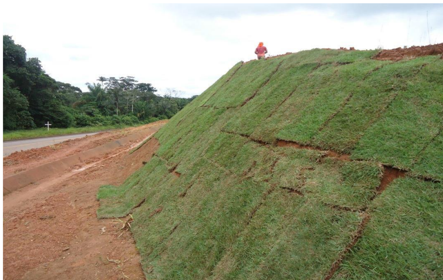
Figura 6 – Aplicação de Grama em Placas (Fonte: SUPRA/DNIT)
