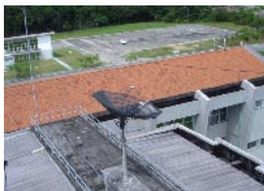
Antena receptora de imagem Goes
