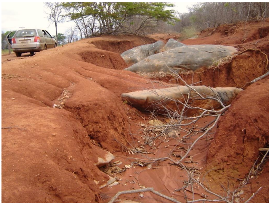
Vala formada ao lado de estrada devido à ausência de barreiras ao escoamento das águas das chuvas. Região norte de Minas Gerais. Foto: Frederico Gonçalves.
