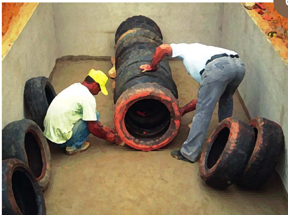
Construção de câmara anaeróbia de pneus usados. Extraído e modificado de Fonseca (2018).
