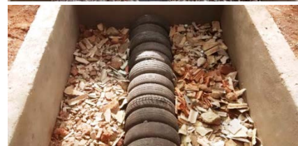
Etapas intermediárias e finais da construção de um TEvap. Fonte: FONSECA (2018)
