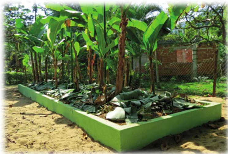
TEvap concluído e com bananeiras em desenvolvimento na Praia do Sono – Paraty/RJ. Fonte: FEC-UNICAMP (2018)
