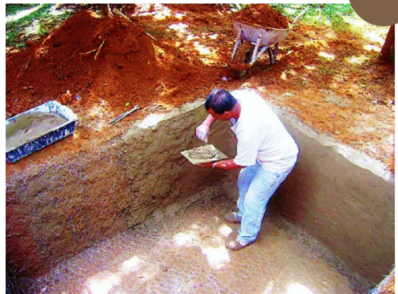
Etapas iniciais da construção de um TEvap. Fonte: LEAL (2014)
