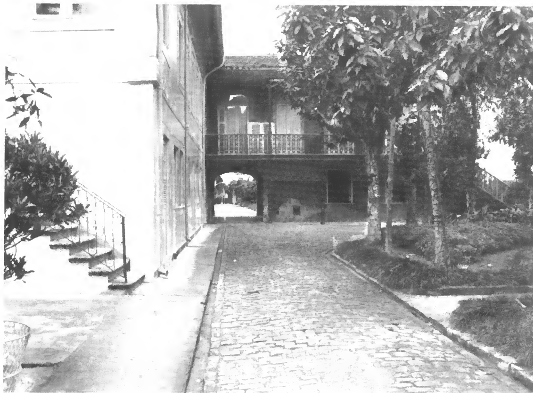
Instalações do Arquivo, até 1978, na ala à esquerda, parte superior, no Corpo do Museu.
