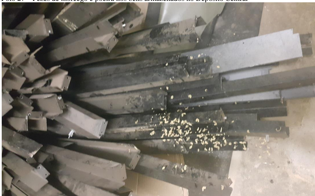
Foto 27 – Fezes de morcego e poeira nos bens armazenados no Depósito Central
