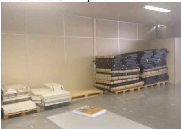
Fotos 37 a 40 -Áreas dos depósitos sem extintores
