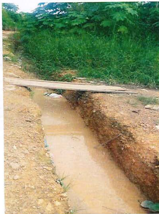
Figura 8: Canal de chorume proveniente do lixão.
