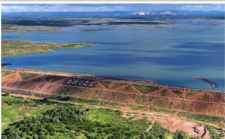
Barragem da mina Casa de Pedra, Congonhas (MG)
