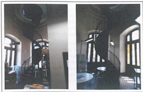
Escadas em espiral para acesso (e escape) aos armazéns de Obras Gerais: à esquerda e à direita do fundo do salão do CPT (3º andar)
