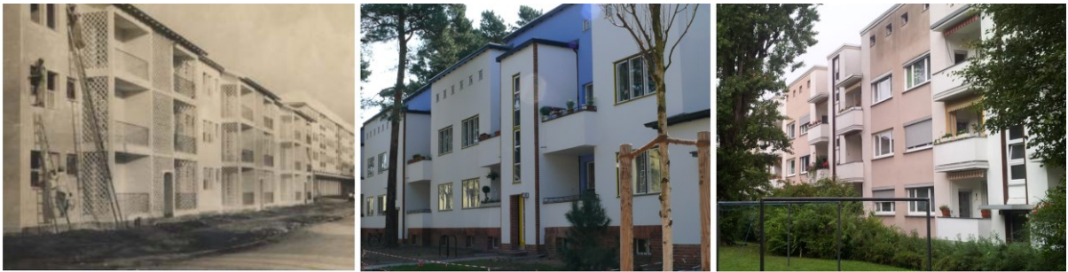
Fig. 42 Carlos Frederico Ferreira, Bloco residencial de três pavimentos, Conjunto Residencial Operário, Realongo, Rio de Janeiro, 1938
