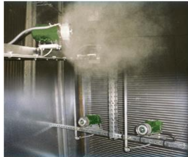
Introdução de vapor de água em uma UTA
