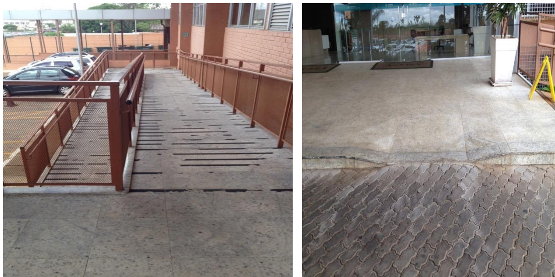
Figura A 3.6.1.5 – Exemplos de rampas de acesso no edifício-sede da Anvisa.
