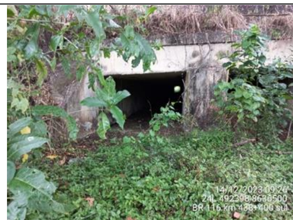
Foto 7-38: Vista geral da passagem de fauna – pista sul. Fonte: VIABAHIA, 14/12/2023.
