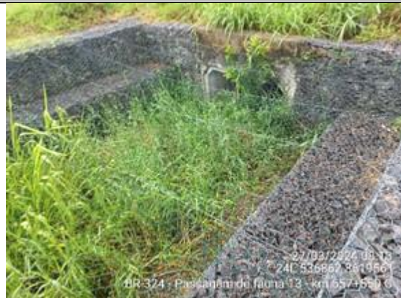
Foto 7-64: Vista geral da passagem de fauna com presença de cerca. Fonte: VIABAHIA, 27/03/2024.
