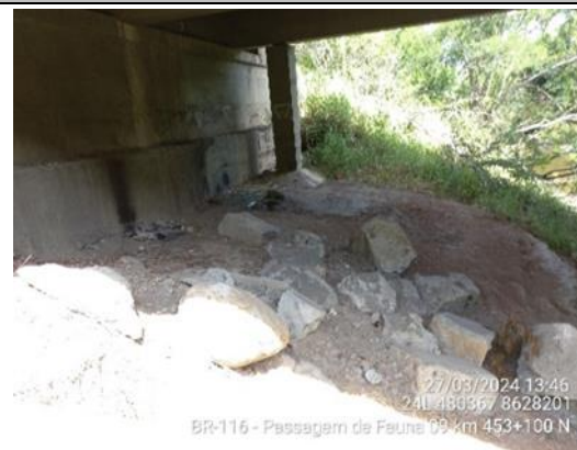
Foto 7-57: Vista geral da passagem de fauna – pista norte. Fonte: VIABAHIA, 27/03/2024.
