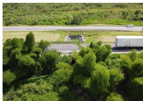
Foto 7-66: Vista geral da passagem de fauna. Fonte: VIABAHIA, 27/03/2024.
