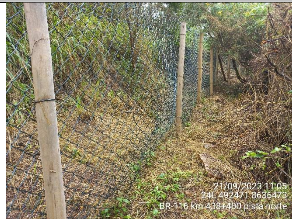
Foto 7-36: Vista geral da passagem de fauna com presença de cerca. Fonte: VIABAHIA, 21/09/2023.
