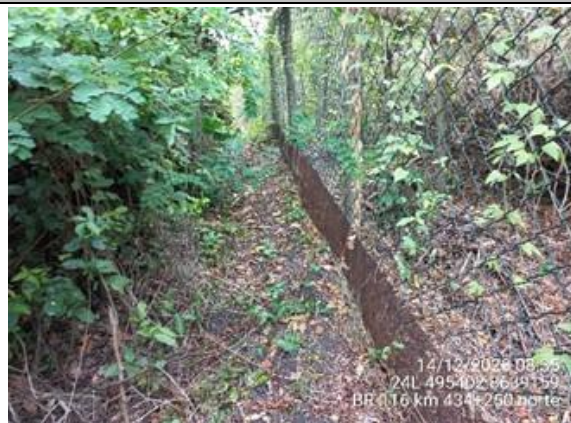
Foto 7-2: Vista geral do cercamento da passagem de fauna. Fonte: VIABAHIA, 14/12/2023.
