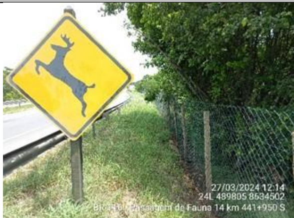
Foto 7-58: Vista geral da passagem de fauna, com a presença de sinalização vertical. Fonte: VIABAHIA, 27/03/2024.
