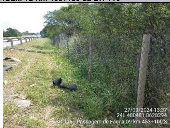
Foto 7-53: Vista geral da passagem de fauna com presença de cerca. Fonte: VIABAHIA, 27/03/2024.
