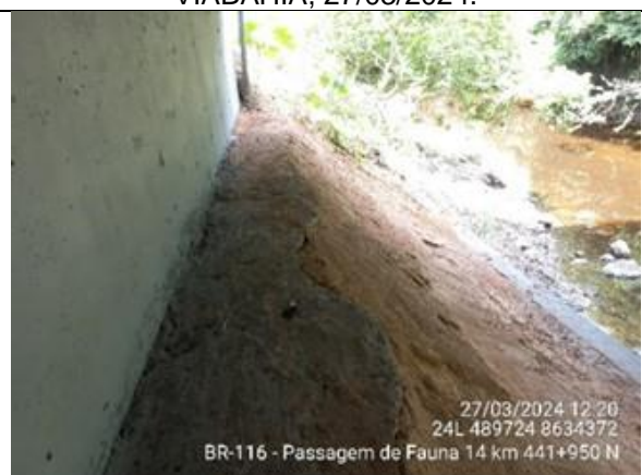
Foto 7-60: Vista geral da passagem de fauna – pista norte. Fonte: VIABAHIA, 27/03/2024.
