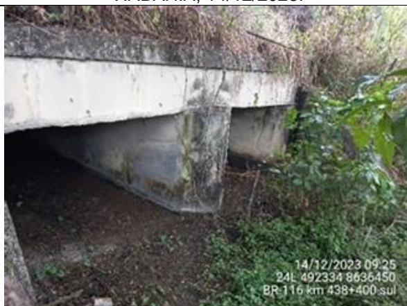
Foto 7-37: Vista geral da passagem de fauna – pista sul. Fonte: VIABAHIA, 14/12/2023.
