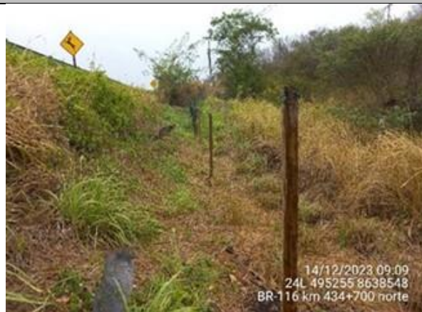
Foto 7-31: Vista geral da passagem de fauna. Fonte: VIABAHIA, 14/12/2023.
