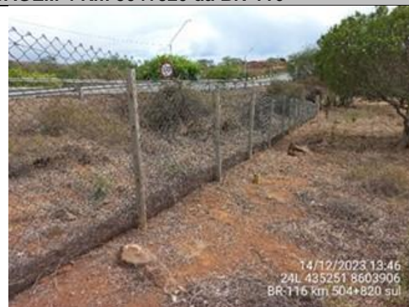
Foto 7-16: Vista geral do cercamento da passagem de fauna. Fonte: VIABAHIA, 14/12/2023.
