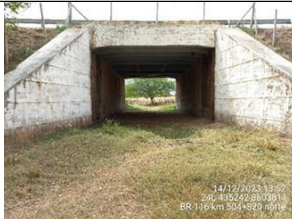
Foto 7-18: Vista geral da entrada da passagem de fauna, destacando a presença de passagem seca para os animais - pista norte. Fonte: VIABAHIA, 14/12/2023.
