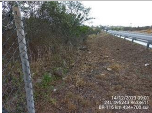
Foto 7-32: Vista geral da passagem de fauna com presença de cerca. Fonte: VIABAHIA, 14/12/2023.
