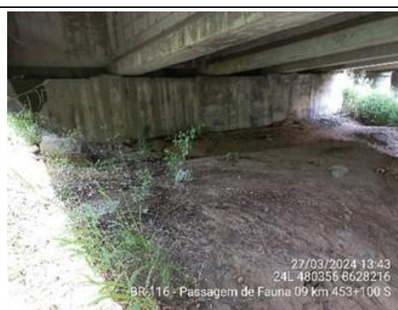
Foto 7-55: Vista geral da passagem de fauna – pista sul. Fonte: VIABAHIA, 27/03/2024.
