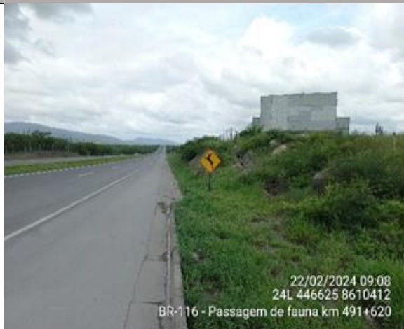
Foto 7-67: Sinalização de fauna silvestre localizada no km 491+620 da BR-116. Fonte: VIABAHIA, 22/02/2024.
