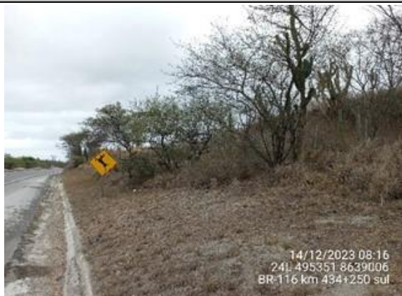
Foto 7-1: Vista geral da passagem de fauna com a presença de sinalização vertical. Fonte: VIABAHIA, 14/12/2023.
