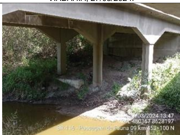
Foto 7-54: Vista geral da passagem de fauna – pista norte. Fonte: VIABAHIA, 27/03/2024.
