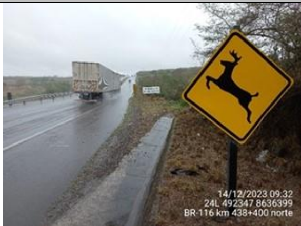
Foto 7-35: Vista geral da passagem de fauna, com a presença de sinalização vertical. Fonte: VIABAHIA, 14/12/2023.
