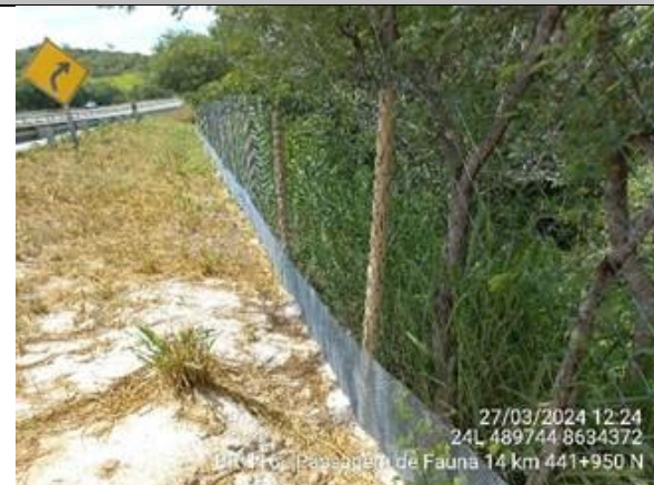
Foto 7-59: Vista geral da passagem de fauna com presença de cerca. Fonte: VIABAHIA, 27/03/2024.
