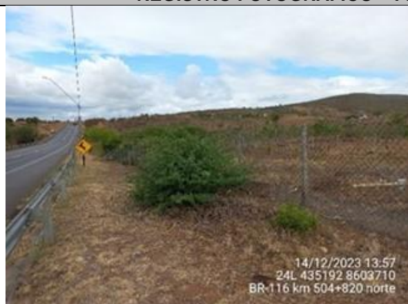
Foto 7-15: Vista geral da passagem de fauna com a presença de sinalização vertical. Fonte: VIABAHIA, 14/12/2023.
