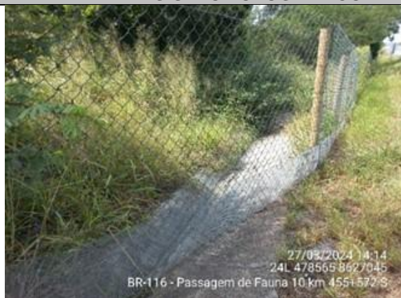
Foto 7-50: Vista geral da cerca presente na passagem de fauna – pista sul. Fonte: VIABAHIA, 27/03/2024.
