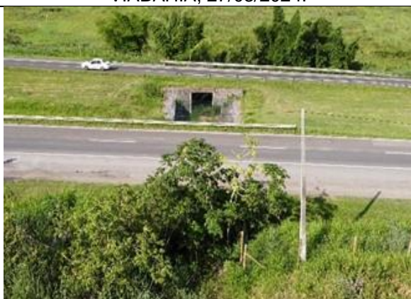
Foto 7-65: Vista geral da passagem de fauna. Fonte: VIABAHIA, 27/03/2024.
