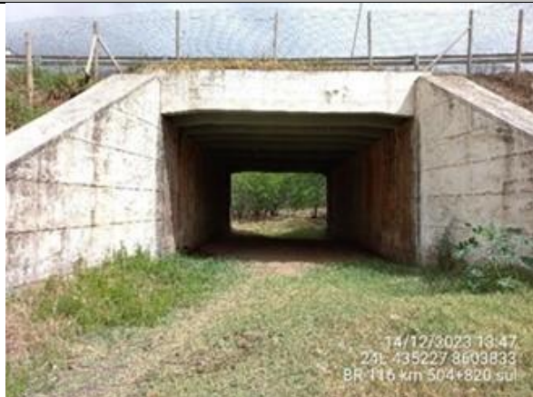
Foto 7-17: Vista geral da entrada da passagem de fauna, destacando a presença de passagem seca para os animais - pista sul. Fonte: VIABAHIA, 14/12/2023.
