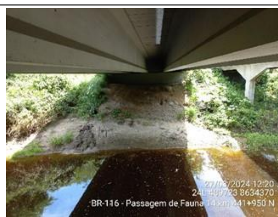
Foto 7-61: Vista geral da passagem de fauna – pista sul. Fonte: VIABAHIA, 27/03/2024.
