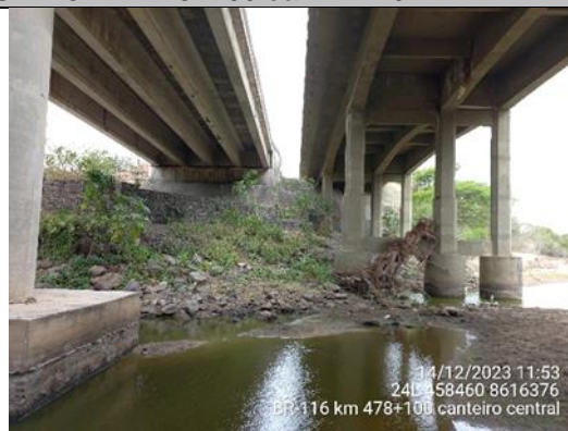
Foto 7-12: Detalhe da passagem seca existente na passagem de fauna. Fonte: VIABAHIA, 14/12/2023.
