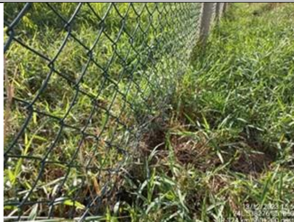
Foto 7-24: Vista geral da passagem de fauna, com presença de cerca. Fonte: VIABAHIA, 13/12/2023.
