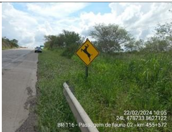
Foto 7-69: Sinalização de fauna silvestre localizada no km 455+572 da BR-116. Fonte: VIABAHIA, 22/02/2024.
