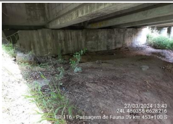
Foto 7-56: Vista geral da passagem de fauna – pista sul. Fonte: VIABAHIA, 27/03/2024.
