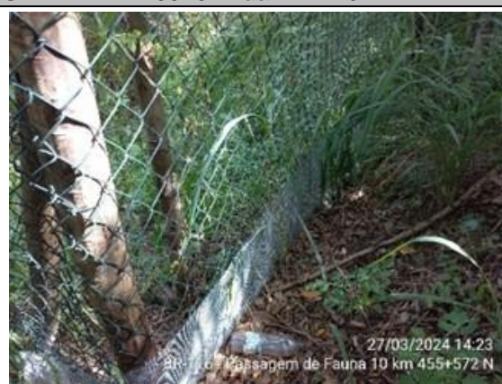
Foto 7-51: Vista geral da cerca presente na passagem de fauna – pista norte. Fonte: VIABAHIA, 27/03/2024.
