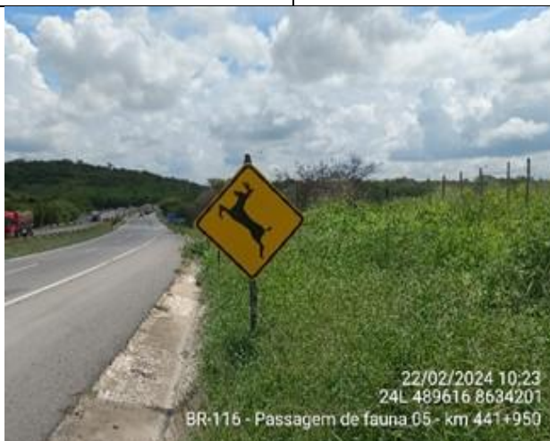
Foto 7-71: Sinalização de fauna silvestre localizada no km 441+950 da BR-116. Fonte: VIABAHIA, 22/02/2024.
