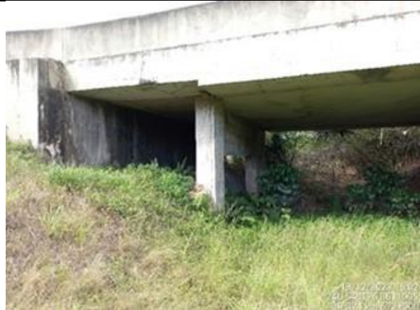
Foto 7-29: Vista geral da saída da passagem de fauna da pista leste. Fonte: VIABAHIA, 13/12/2023.
