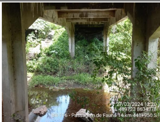
Foto 7-62: Vista geral da passagem de fauna – pista sul. Fonte: VIABAHIA, 27/03/2024.
