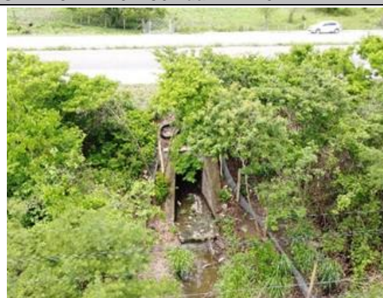
Foto 7-45: Vista geral da passagem de fauna – pista sul. Fonte: VIABAHIA, 27/03/2024.
