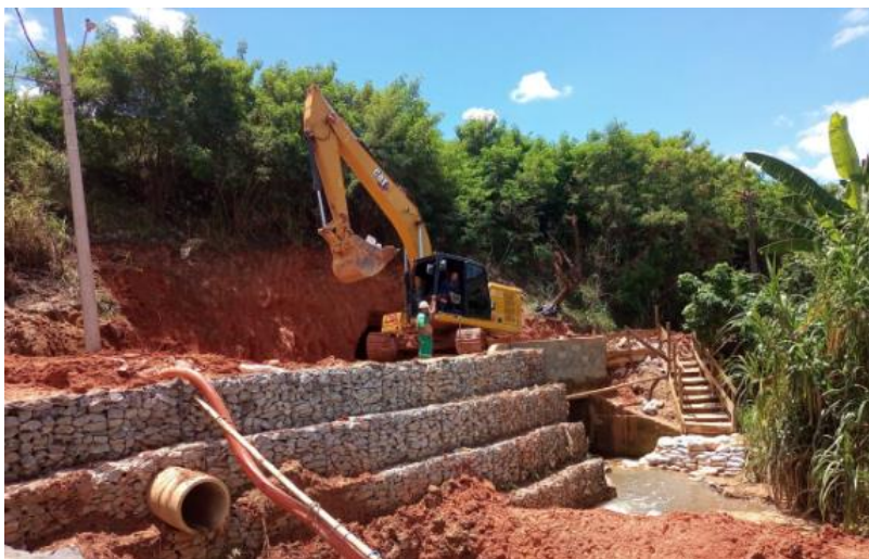
Figura 22: Recuperação do sistema de drenagem lado sul (em andamento – mar/24)
