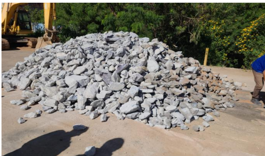
Figura 25: Material utilizado para execução do enrocamento de pedras (em andamento – abr/24)
