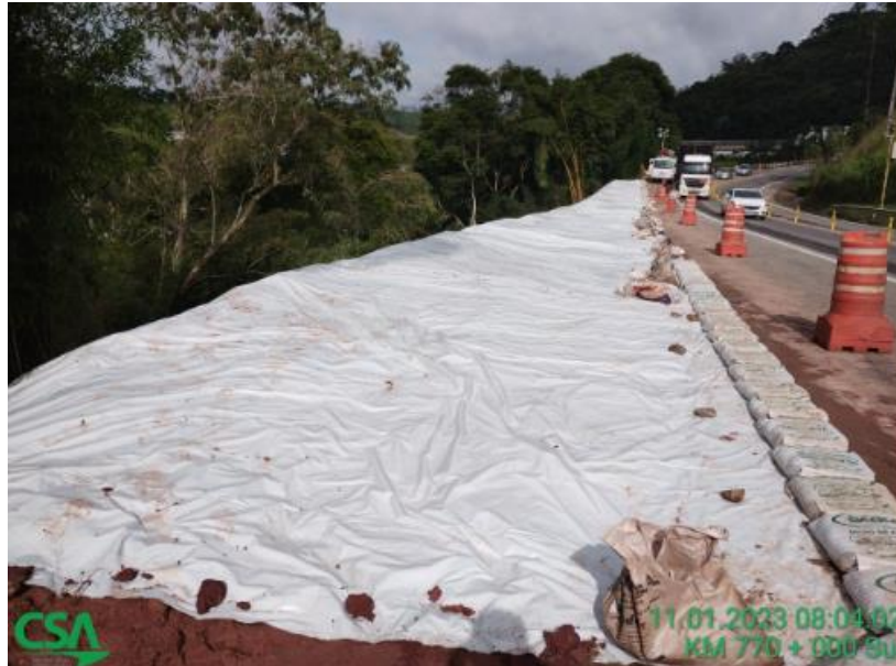
Figura 18: Recomposição de talude (finalizado – mar/23)
