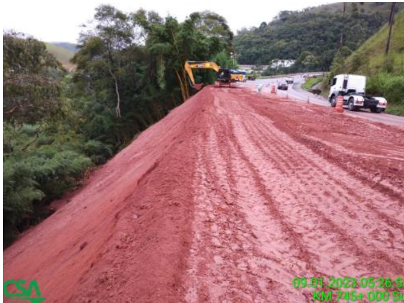
Figura 17: Recomposição de talude e revegetação (finalizado – mar/23)
