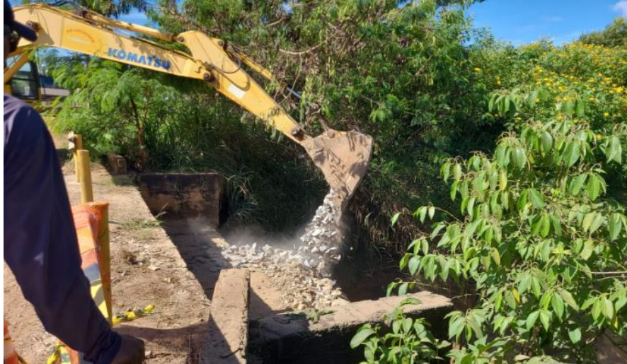
Figura 26: Execução do enrocamento de pedras (em andamento – abr/24)
