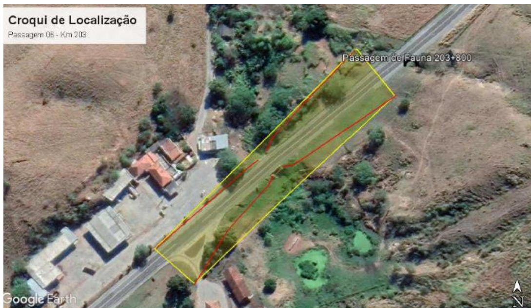
Figura 6 - Passagem de Fauna km 203+800
