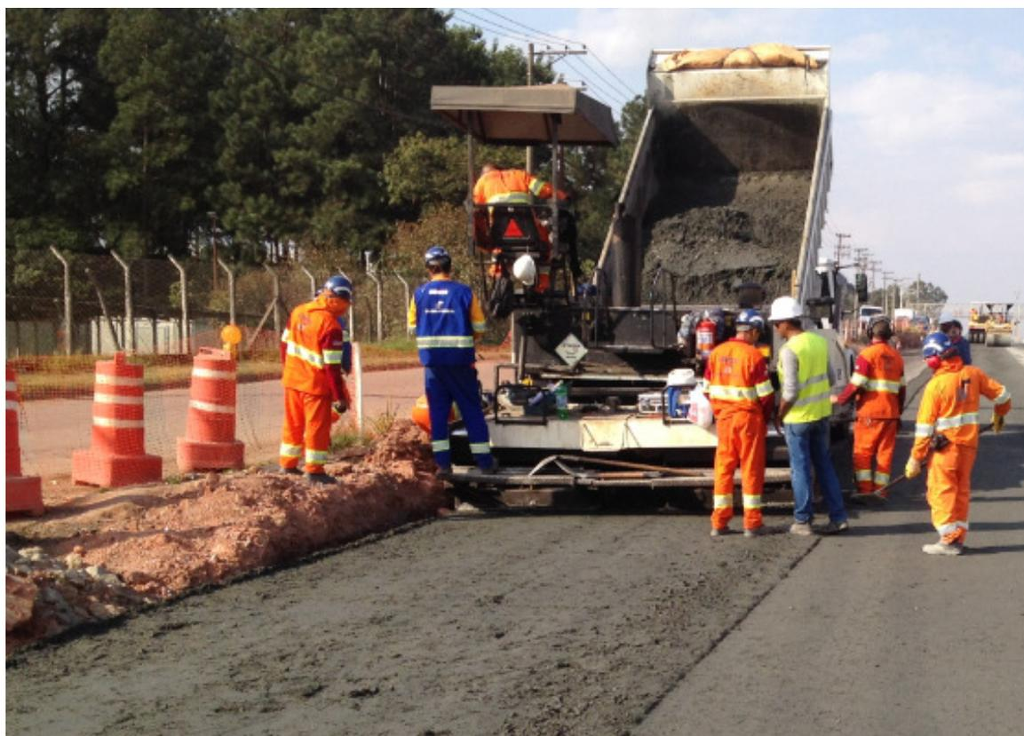
Figura 3.5: Espalhamento de BGTC com vibro-acabadora
