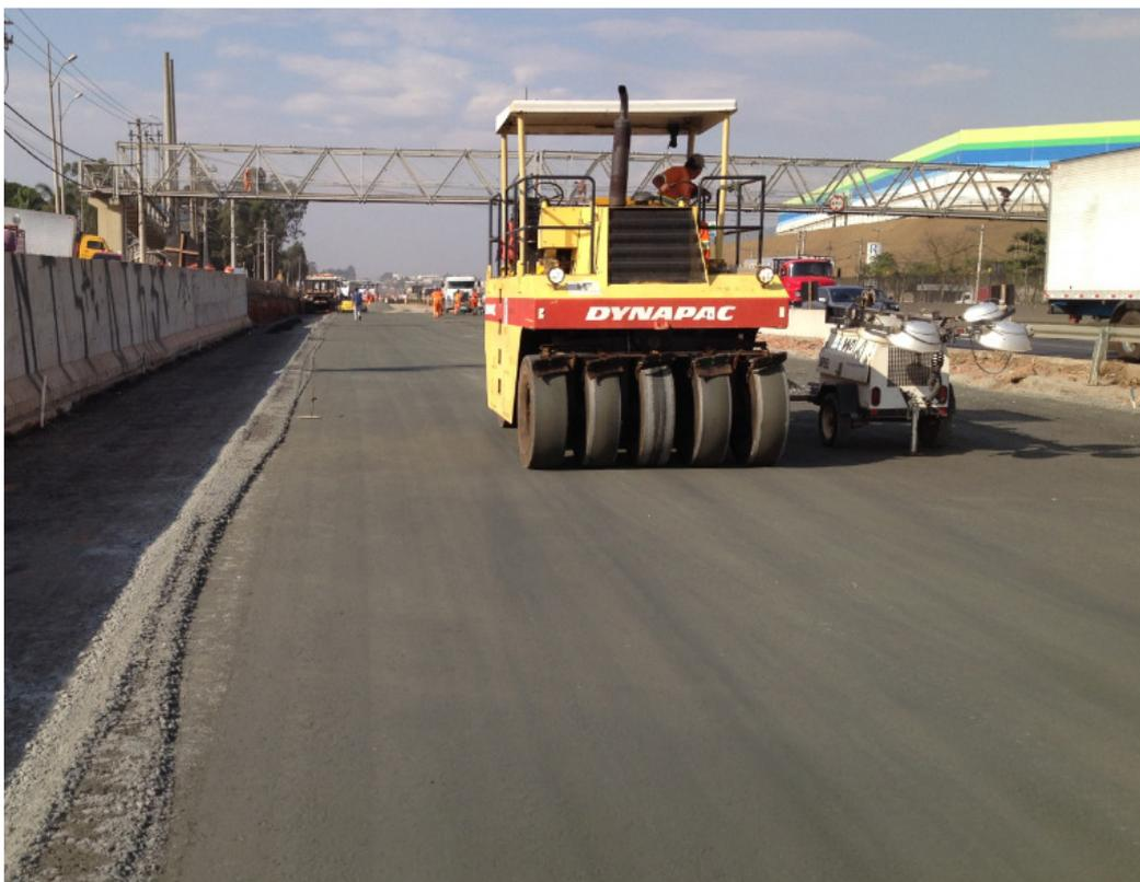
Figura 3.6: Compactação da BGTC com rolo compactador pneumático
