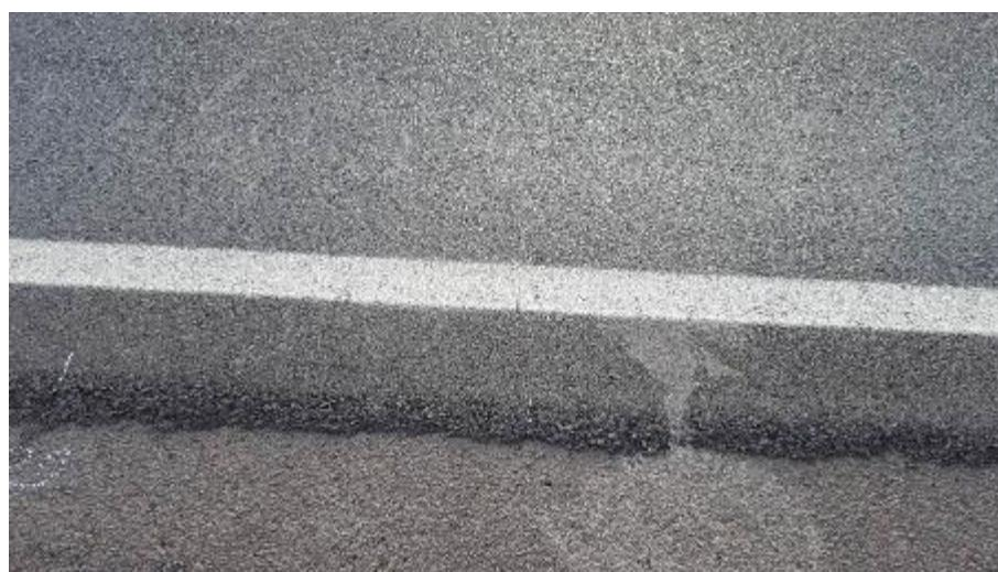
Foto 112- Vista dos defeitos tipo trincas transversais curtas com bombeamento de finos na distância de 20 m na trilha externa.
