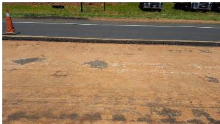
Foto 31 - Vista dos defeitos na base de solo-cimento na distância de 55m.
