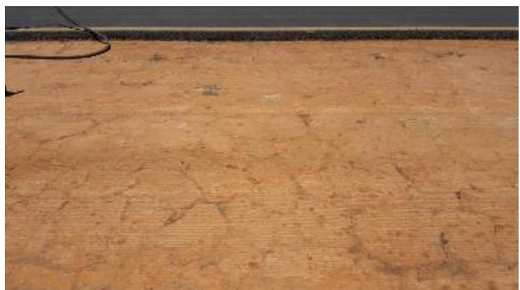
Foto 21 - Vista dos defeitos na base de solo-cimento na distância de 5m.
