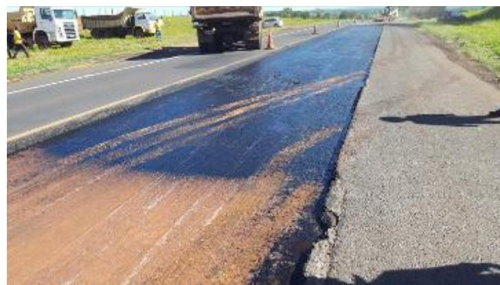
Foto 79- Vista da transição entre o subtrecho 1, onde foi aplicado o produto “DUROCK”, e o subtrecho 2, onde foi aplicada a pintura de ligação com emulsão asfáltica tipo RR-2C diluída com 30% de água.
