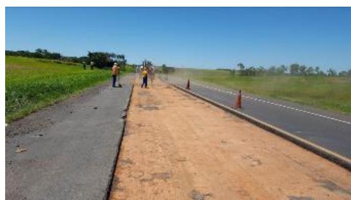
Foto 62- Vista da limpeza com compressor da sujeira sobre a base de solo-cimento.
