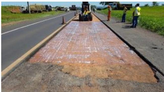
Foto 64- Vista da aplicação do produto "DUROCK" sobre a base de solo-cimento.
