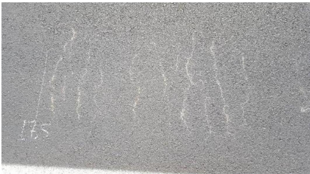
Foto 110 - Vista dos defeitos tipo trincas transversais curtas com bombeamento de finos na distância de 17,5 m na trilha externa.
