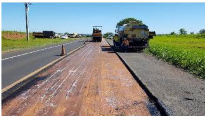
Foto 69- Vista da passagem do rolo pneumático sobre o produto “DUROCK”.
