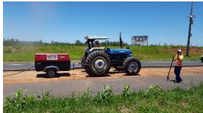
Foto 60- Vista do equipamento utilizado na limpeza com compressor da sujeira sobre a base de solo-cimento.
