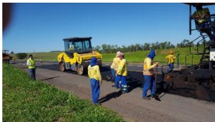
Foto 73- Início da compactação da 1ª camada de CBUQ com o rolo liso tandem duplo.
