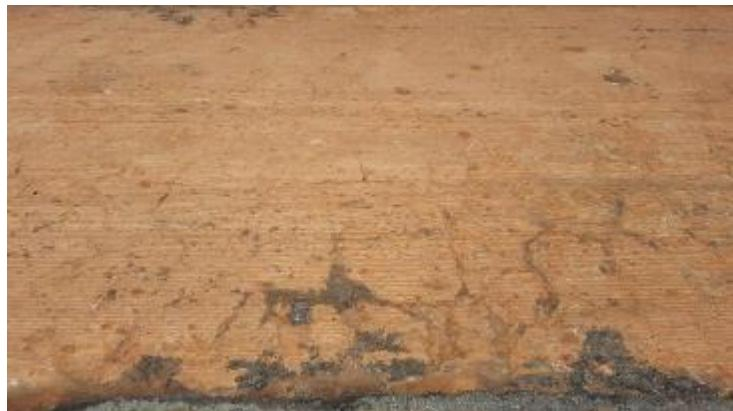
Foto 28 - Vista dos defeitos na base de solo-cimento na distância de 40m.
