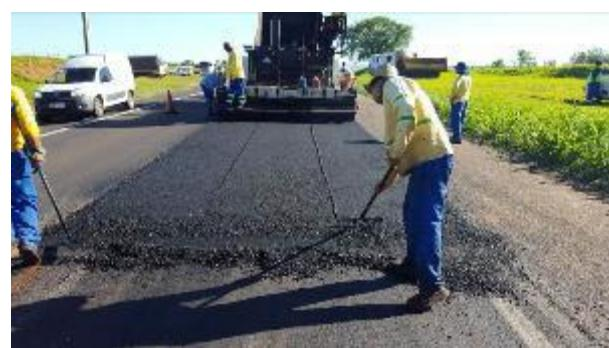
Foto 77- Vista do início da execução da 2<sup>a</sup> camada de CBUQ executada de maneira semelhante a primeira camada.
