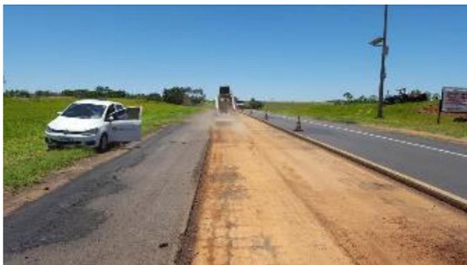
Foto 59- Vista da limpeza da superfície da base de solo-cimento com a vassoura mecânica, após a fresagem.
