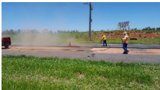
Foto 61- Vista da limpeza com compressor da sujeira sobre a base de solo-cimento.
