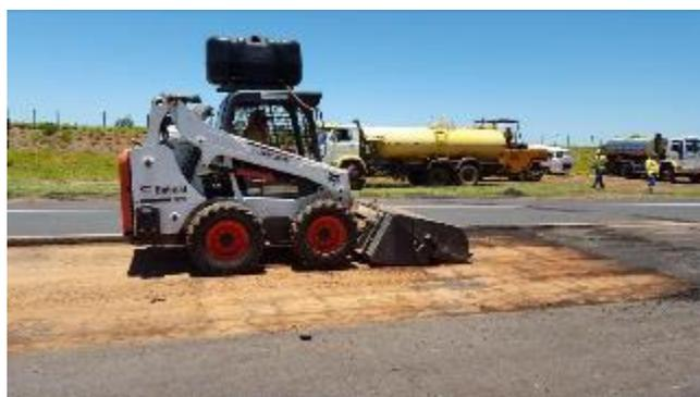
Foto 58- Vista do início da limpeza da superfície da base de solo-cimento com a vassoura mecânica, após a fresagem.
