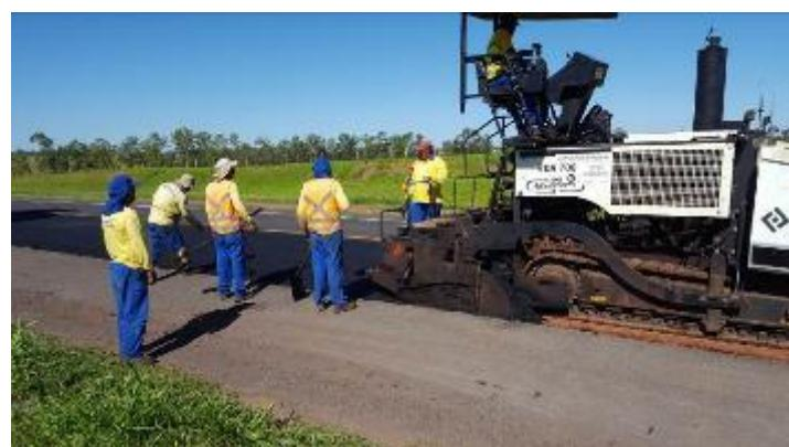
Foto 72- Aplicação do CBUQ da 1<sup>a</sup> camada sobre a base de solo-cimento imprimada com o produto “DUROCK”.
