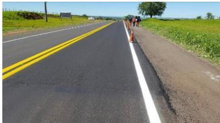
Foto 52- Vista geral do trecho experimental após a aplicação da sinalização horizontal.
