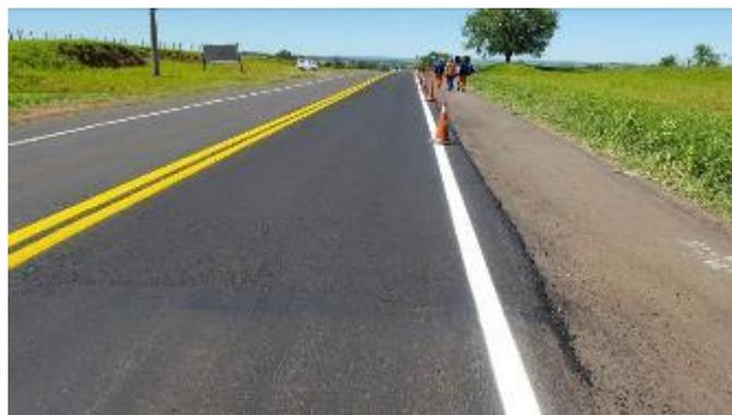
Foto 85- Vista geral dos dois subtrechos com a sinalização horizontal executada.
