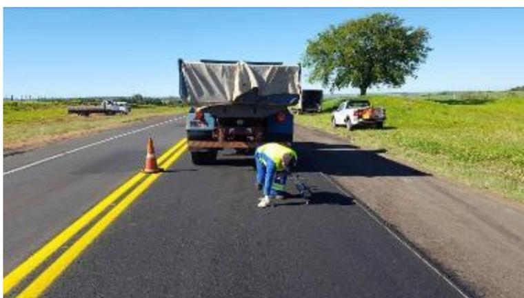
Foto 49- Vista do levantamento de deflexões reversíveis no revestimento asfáltico executado sobre a base de solo-cimento.
