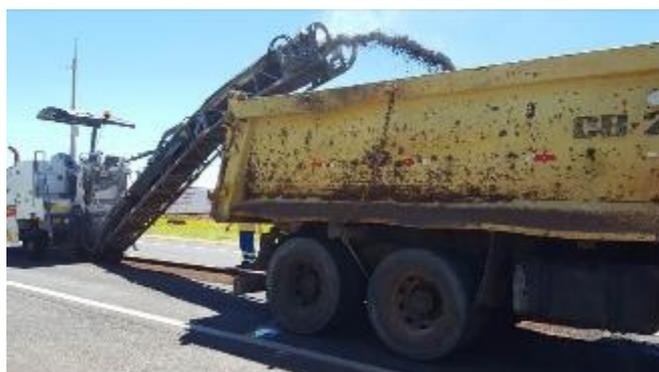
Foto 56- Vista da fresagem do revestimento asfáltico primitivo.
