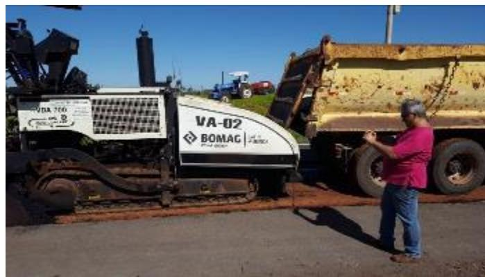
Foto 71- Início da aplicação do CBUQ da 1<sup>a</sup> camada sobre a base de solo-cimento imprimada com o produto “DUROCK”.
