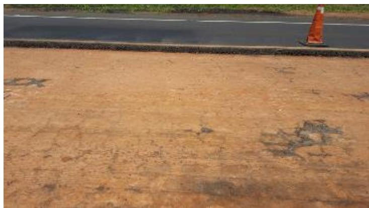
Foto 30 - Vista dos defeitos na base de solo-cimento na distância de 50m.
