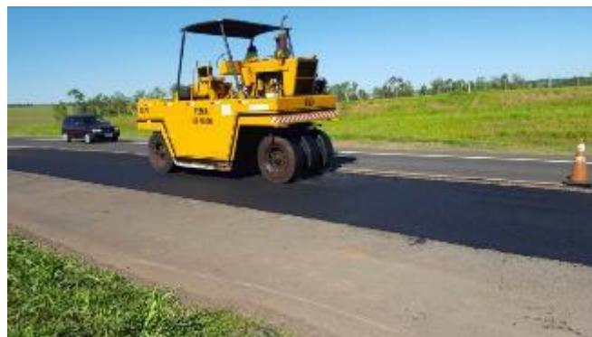
Foto 74- Vista da compactação da 1<sup>a</sup> camada de CBUQ com o rolo pneumático.
