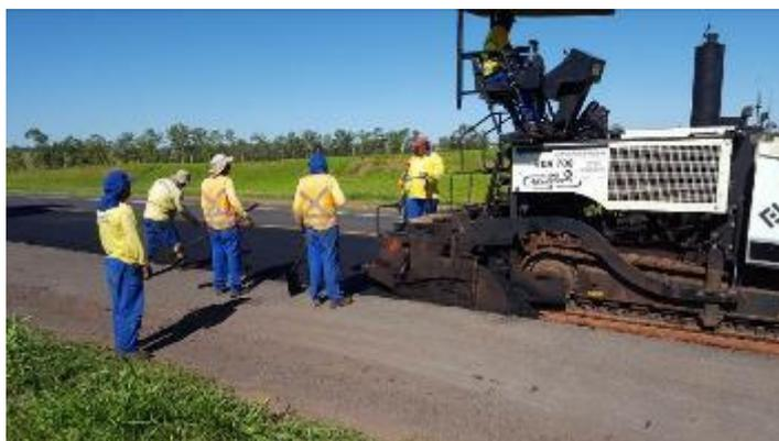
Foto 72- Aplicação do CBUQ da 1ª camada sobre a base de solo-cimento imprimada com o produto “DUROCK”.
