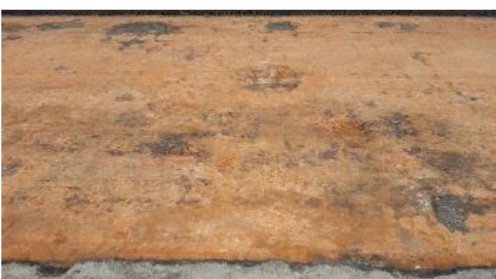
Foto 27 - Vista dos defeitos na base de solo-cimento na distância de 35m.
