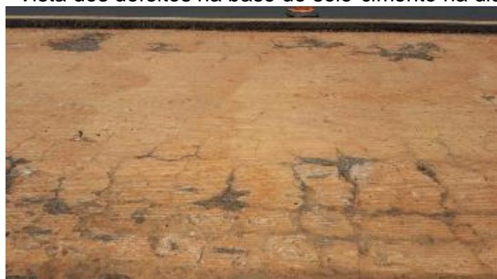
Foto 35 - Vista dos defeitos na base de solo-cimento na distância de 75m.
