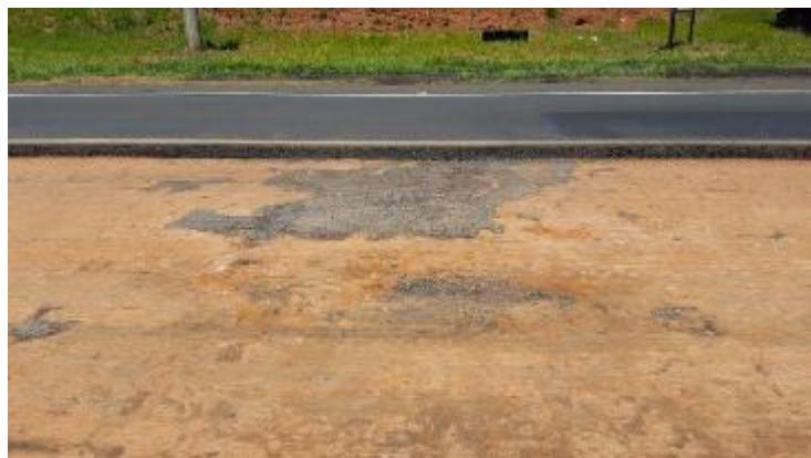
Foto 29 - Vista dos defeitos na base de solo-cimento na distância de 45m.
