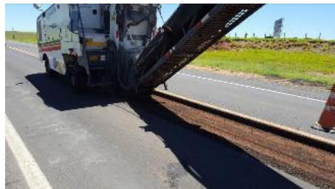
Foto 55- Vista da superfície da base de solo-cimento na área fresada.
