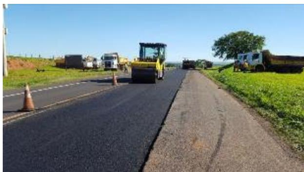
Foto 76- Vista do acabamento final com o rolo tandem liso vibratório.
