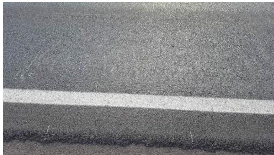
Foto 111- Vista dos defeitos tipo trincas transversais curtas com bombeamento de finos na distância de 18 m a 19 m na trilha externa
