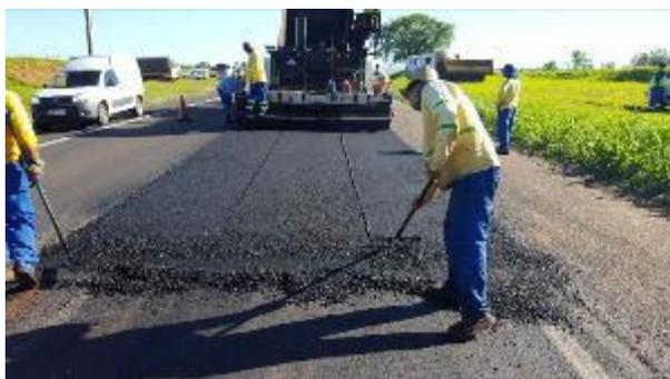
Foto 77- Vista do início da execução da 2ª camada de CBUQ executada de maneira semelhante a primeira camada.
