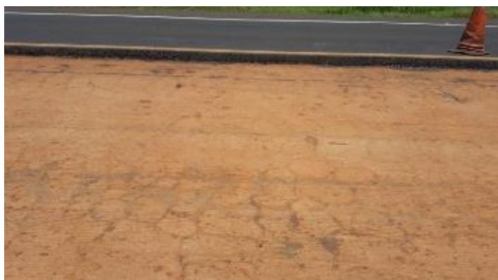
Foto 25 - Vista dos defeitos na base de solo-cimento na distância de 25m.
