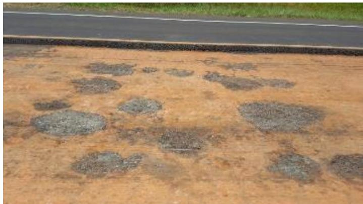
Foto 24 - Vista dos defeitos na base de solo-cimento na distância de 20m.
