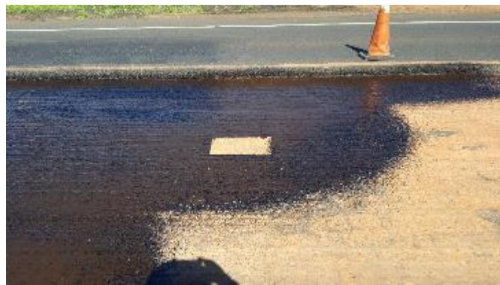
Foto 80- Vista da aplicação da pintura de ligação no segundo trecho. Notar o local de colocação da bandeja para determinação da taxa de emulsão asfáltica.
