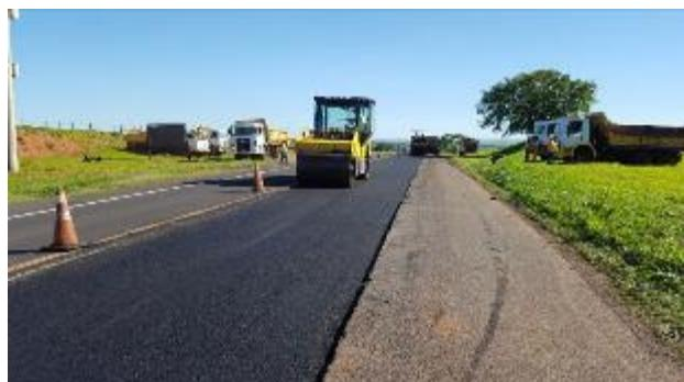
Foto 76- Vista do acabamento final com o rolo tandem liso vibratório.
