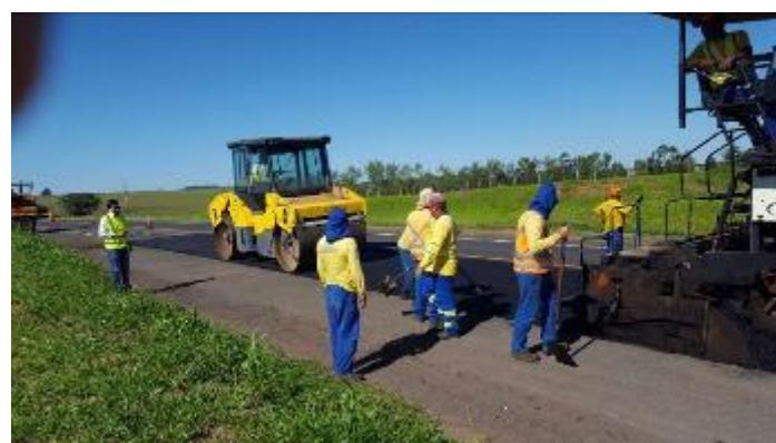
Foto 73- Início da compactação da 1<sup>a</sup> camada de CBUQ com o rolo liso tandem duplo.
