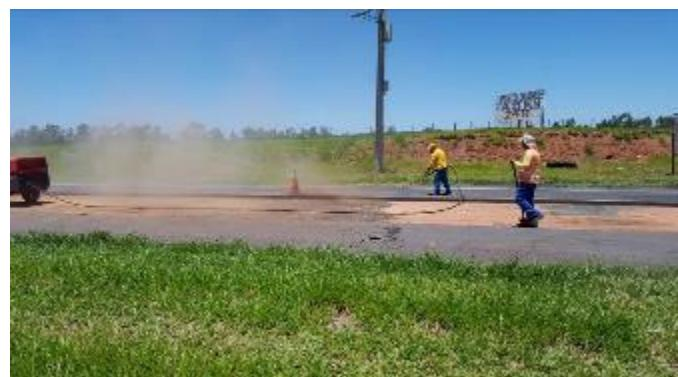
Foto 61- Vista da limpeza com compressor da sujeira sobre a base de solo-cimento.
