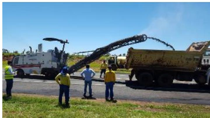
Foto 54- Vista do início da fresagem do revestimento primitivo.
