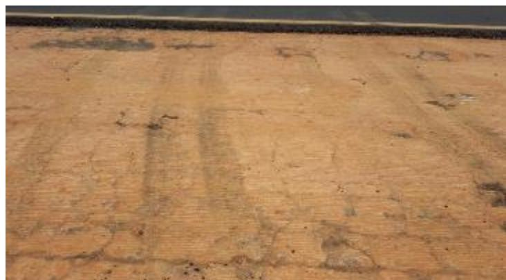
Foto 34 - Vista dos defeitos na base de solo-cimento na distância de 70m.
