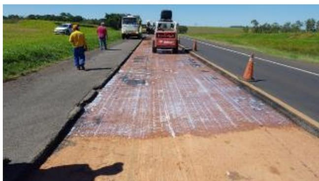
Foto 67- Vista da reaplicação do produto "DUROCK" para completar a taxa de aplicação.
