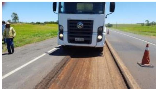
Foto 57- Vista da fresagem do revestimento asfáltico primitivo.
