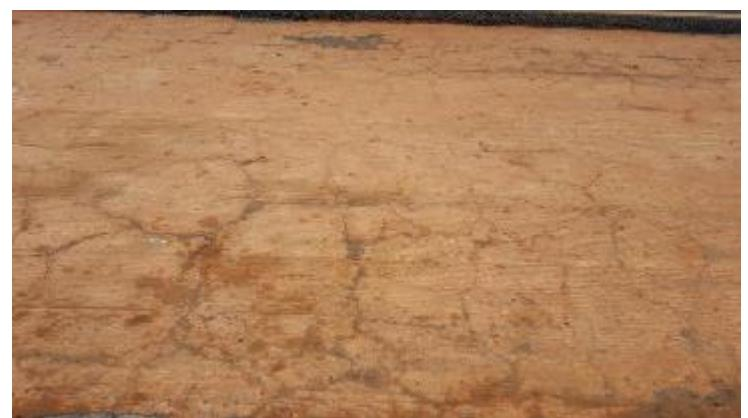
Foto 22 - Vista dos defeitos na base de solo-cimento na distância de 10m.
