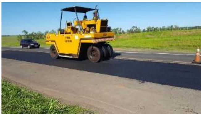
Foto 74- Vista da compactação da 1ª camada de CBUQ com o rolo pneumático.
