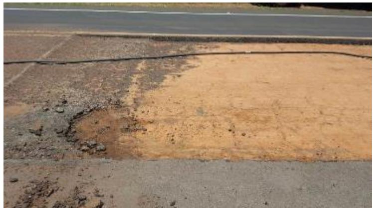
Foto 20 - Vista dos defeitos na base de solo-cimento na distância de 0m.
