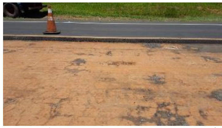
Foto 23 - Vista dos defeitos na base de solo-cimento na distância de 15m.
