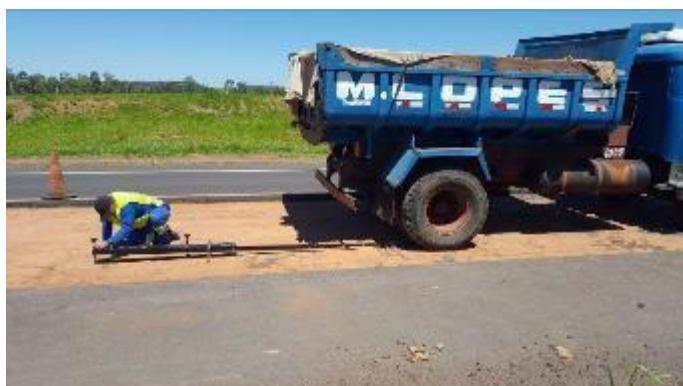
Foto 44- Vista do levantamento de deflexões reversíveis na base de solo-cimento.
