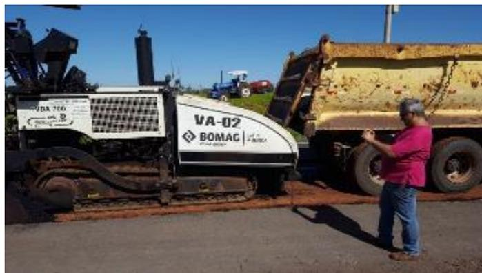
Foto 71- Início da aplicação do CBUQ da 1ª camada sobre a base de solo-cimento imprimada com o produto “DUROCK”.
