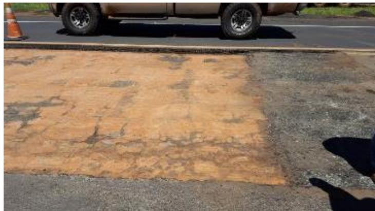
Foto 36 - Vista dos defeitos na base de solo-cimento na distância de 80m.
