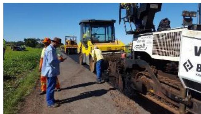
Foto 75- Vista da compactação com o rolo tandem liso sem vibrar seguido do rolo pneumático.
