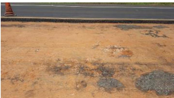
Foto 26 - Vista dos defeitos na base de solo-cimento na distância de 30m.
