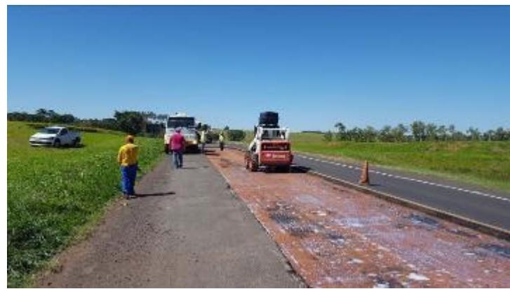
Foto 68- Vista da reaplicação do produto “DUROCK” para completar a taxa de aplicação.
