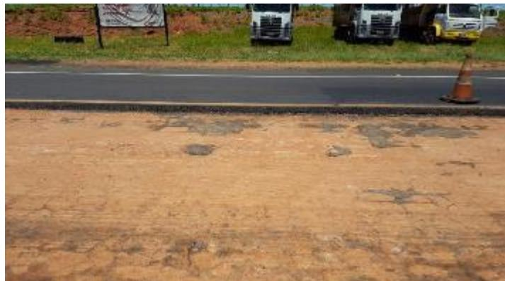
Foto 32 - Vista dos defeitos na base de solo-cimento na distância de 60m.
