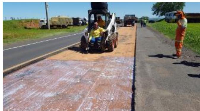
Foto 66- Vista do produto “DUROCK” antes da evaporação da água sobre a base de solo-cimento.
