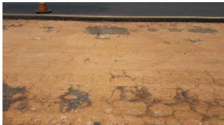
Foto 33 - Vista dos defeitos na base de solo-cimento na distância de 65m.
