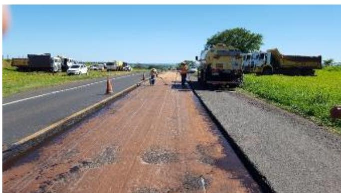
Foto 70- Vista da aplicação da ligação apenas nas bordas do pavimento primitivo no primeiro subtrechos.
