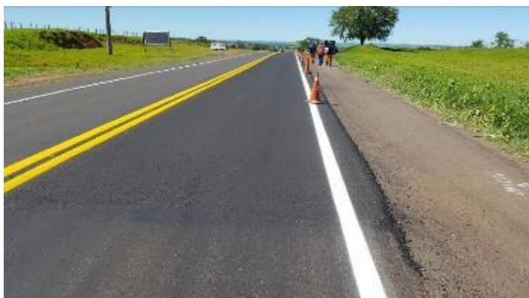
Foto 52- Vista geral do trecho experimental após a aplicação da sinalização horizontal.
