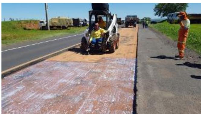
Foto 66- Vista do produto "DUROCK" antes da evaporação da água sobre a base de solo-cimento.
