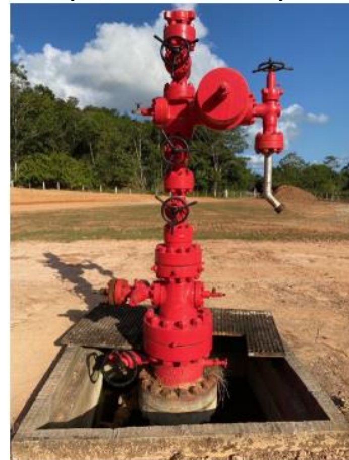
Poço ANTES da intervenção
